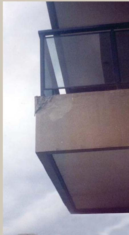
O chumbador em material ferroso corrói e expulsa o concreto, emboço, reboco etc.
