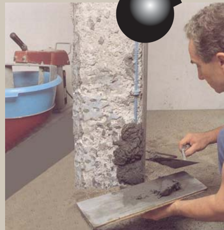
O tratamento da corrosão pelo método antigo.
