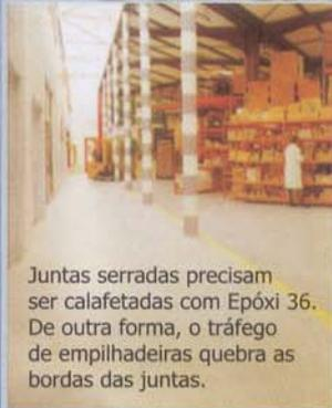
Juntas serradas precisam ser calafetadas com Epóxi 36. De outra forma, o tráfego de empilhadeiras quebra as bordas das juntas.
