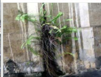
Ferragens expostas, eflorescências e vegetação crescendo nas juntas da estrutura mostram a degradação do viaduto. Como estará sua condição estrutural?
