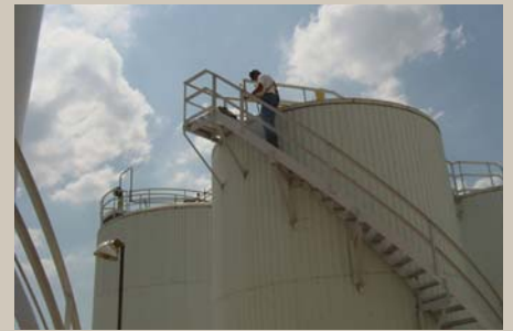
Figura 2 - Tanques necessitam de boa preparação das superfícies e pintura adequada.
