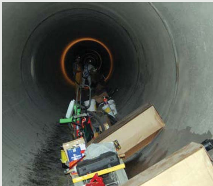
Caixas com rolos de fibra de carbono MFC, resinas epóxicas posicionadas em trechos estratégicos para ataque em diversas frentes.
