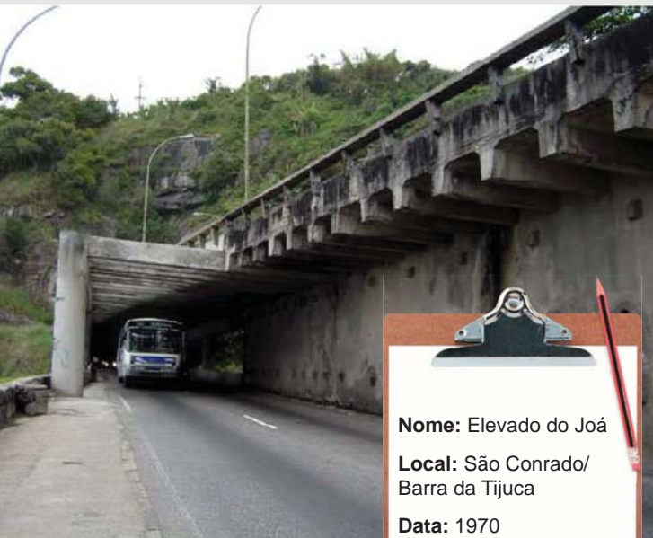
Processos de corrosão para todos os gostos, em vigas, lajes e pilares, juntas destruídas, etc.
