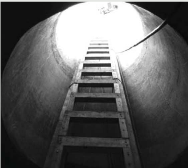
Poço de visita: o único acesso ao interior da TACCP, com diâmetro de ~ 80cm.
