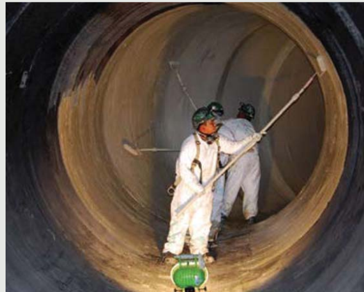
Pintura final de proteção do processo de reforço: epóxi novolac.
