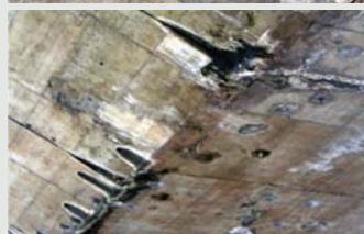
Ferragens expostas, eflorescências e vegetação crescendo nas juntas da estrutura mostram a degradação do viaduto. Como estará sua condição estrutural?
