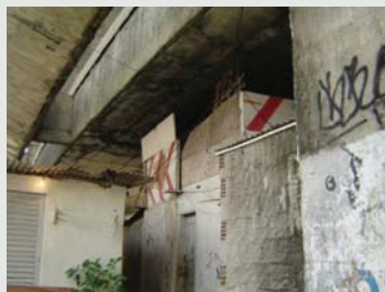
Estrutura com armaduras expostas, erosão da base e moradias irregulares sob o viaduto são problemas flagrantes.
