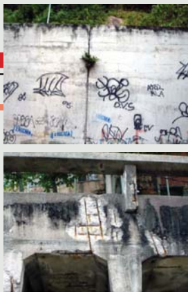
Processos de corrosão para todos os gostos, em vigas, lajes e pilares, juntas destruídas, etc.
