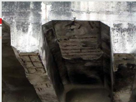
Processos de corrosão para todos os gostos, em vigas, lajes e pilares, juntas destruídas, etc.
