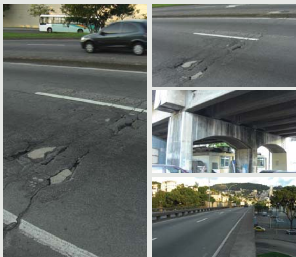
Buracos que posicionam uma junta de dilatação esquecida, sinais de corrosão em algumas peças estruturais.
