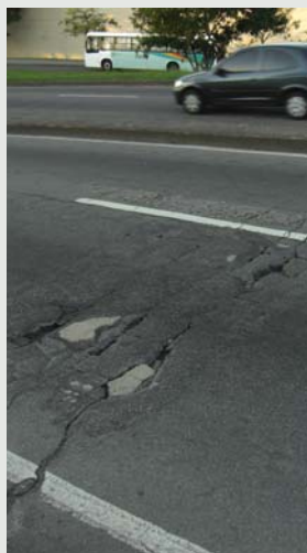
Buracos que posicionam uma junta de dilatação esquecida, sinais de corrosão em algumas peças estruturais.
