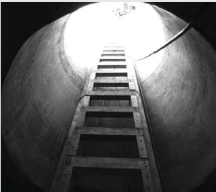
Poço de visita: o único acesso ao interior da TACCP, com diâmetro de ~ 80cm.
