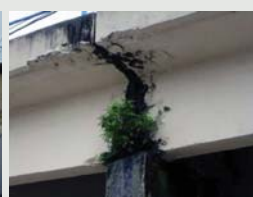
Problemas de infiltração e descolamentos da camada de recobrimento do concreto, além de vegetação crescendo entre as juntas de dilatação.
