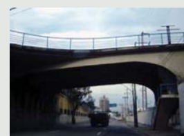
Problemas de infiltração e descolamentos da camada de recobrimento do concreto, além de vegetação crescendo entre as juntas de dilatação.
