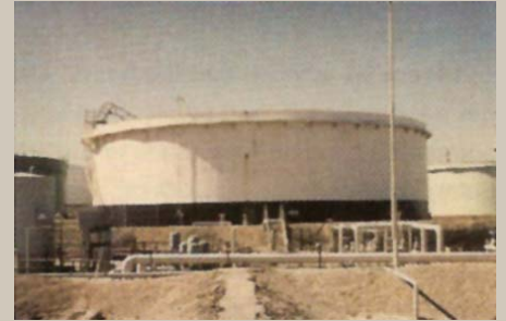
Figura 3 - Tintas alquídicas são bastante indicadas para tanques industriais.
