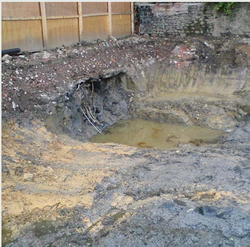
Contaminação do solo imediatamente abaixo da laje radier de um tanque que estocava alcatrão. Repare a laje radier cortada como referencial.
