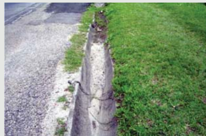
Sistema de drenagem interrompido pode provocar problemas de deslizamentos no talude.
