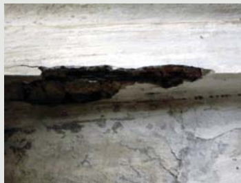
Problemas de infiltração e descolamentos da camada de recobrimento do concreto, além de vegetação crescendo entre as juntas de dilatação.
