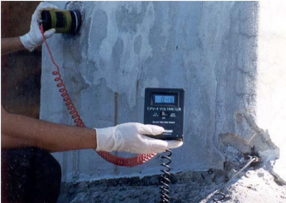
Figura 7: Semi-pilha portátil no levantamento do estado de corrosão no concreto armado.
