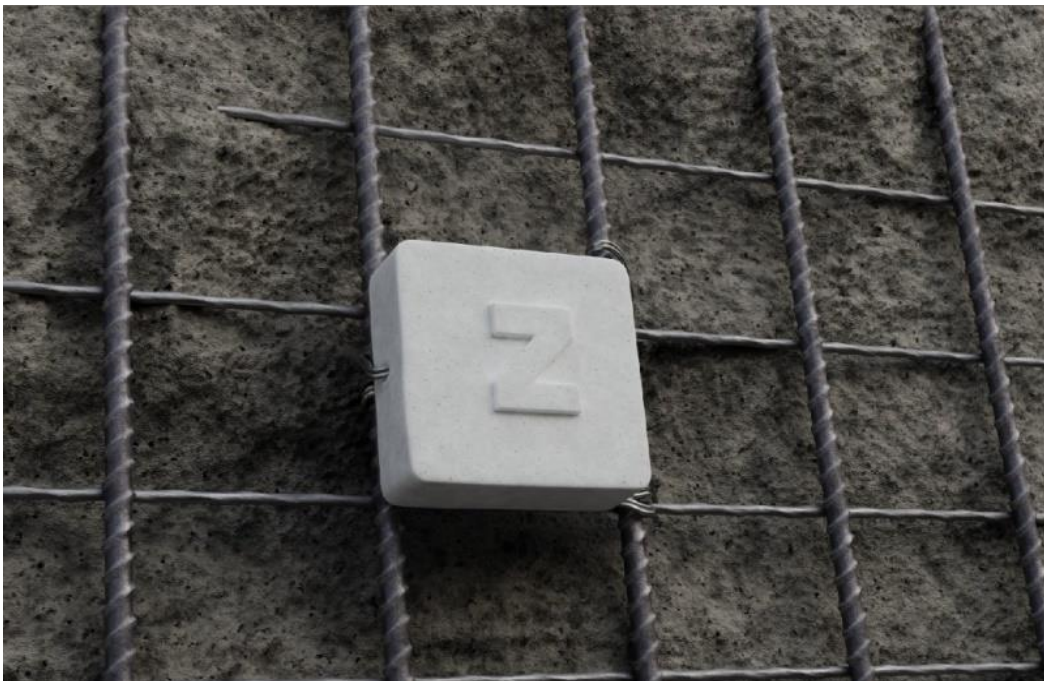
Figura 25: Instalação da Pastilha Z.
