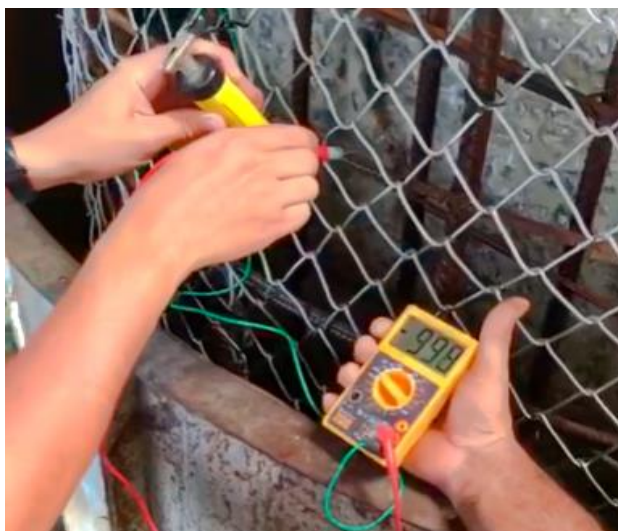
Figura 30: Certificação do potencial de proteção, após a instalação do anodo galvânico na forma de tela, utilizando-se eletrodo SCS, antes da concretagem.
