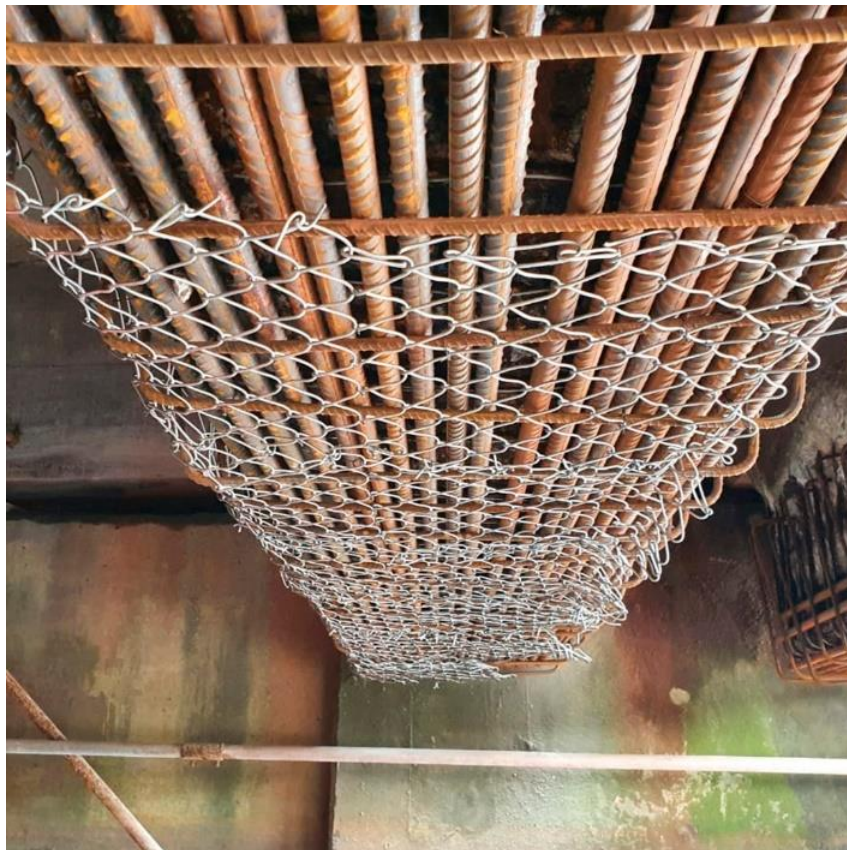
Figura 27: Instalação da Tela G.
