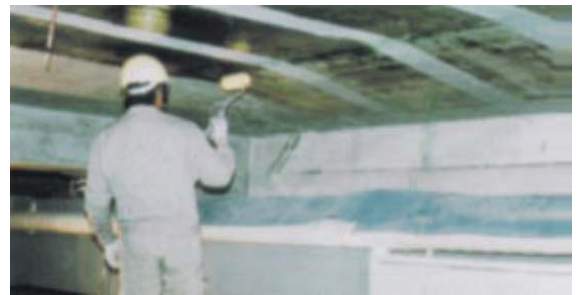
Com o mínimo de mão de obra é possível executar grandes áreas de reforço em lajes.
