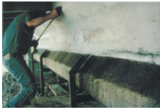
Vigas ou longarinas de pontes...
