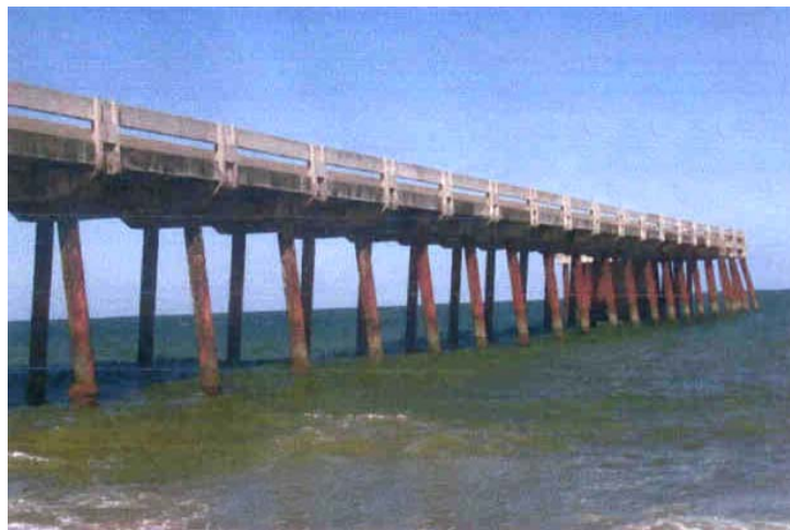
Situação comum de piers com estacas metálicas.
