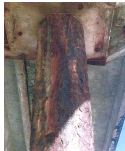
No detalhe a situação da camisa metálica.
