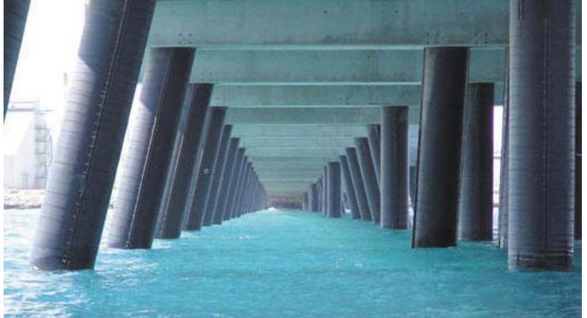
Situação final, após a instalação da ESPIRAL G: estacas adequadamente protegidas contra a corrosão do mar.
