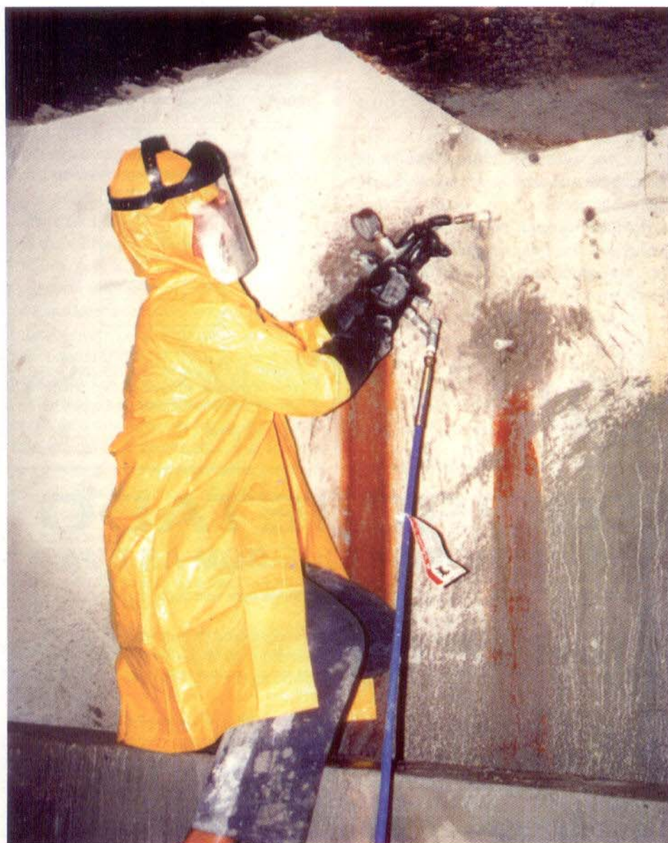
Poliuretano sendo injetado em parede diafragma no 3º subsolo de uma edificação no Rio de Janeiro. Antes de injetar o poliuretano injeta-se água para se testar a comunicação entre os injetores.
