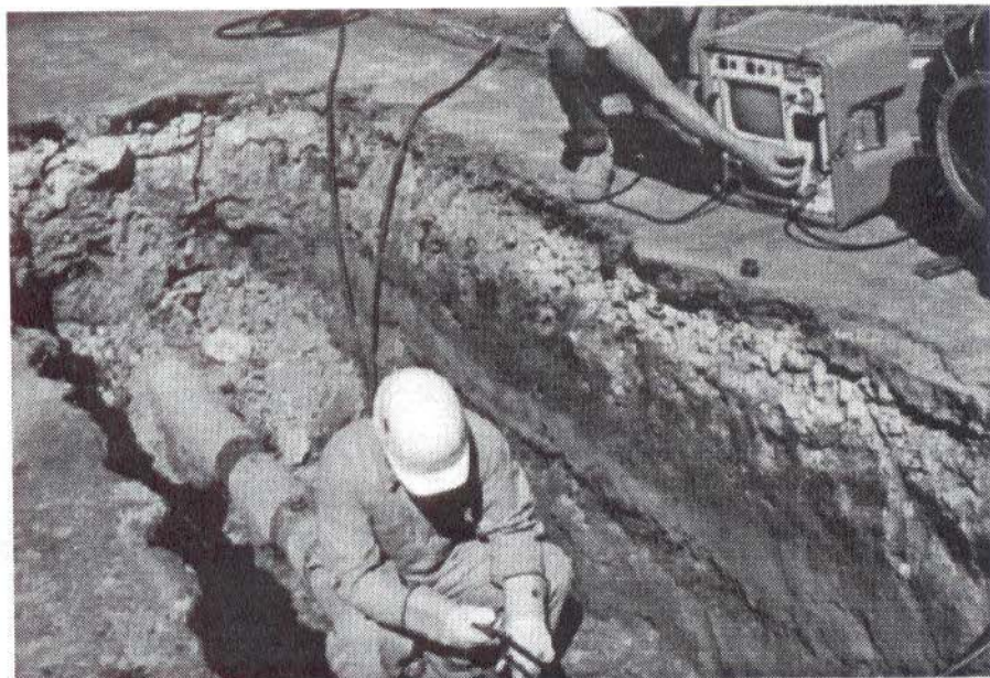
O gascan sendo introduzido em um gasoduto. Pode inspecionar cerca de 100 metros de gasodutos, oleodutos, e tubulações de esgoto, rapidamente, sem interrupção do serviço.
