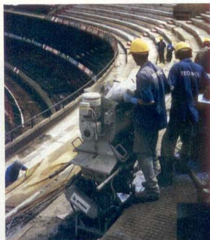
Obra de Recuperação Estádio do Morumbi Janeiro/95
