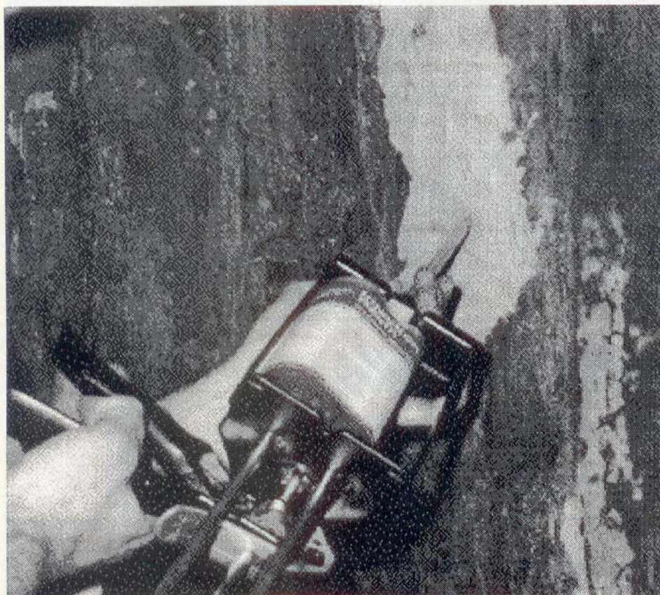
Figura 2 — O epóxi de cura rápida usado com esta pistola de cartucho duplo permite instalar âncoras para serem rapidamente utilizadas.
