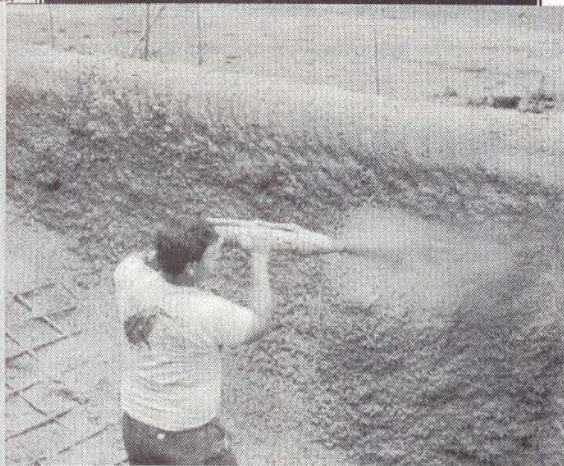
O uso de aditivos no concreto projetado faz aumentar a durabilidade do concreto e a produtividade da obra, com a redução substancial das perdas por reflexão.
