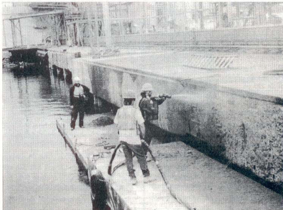
Aplicação de concreto projetado, via seca, com uso de fibras de aço, em parede de pier.
