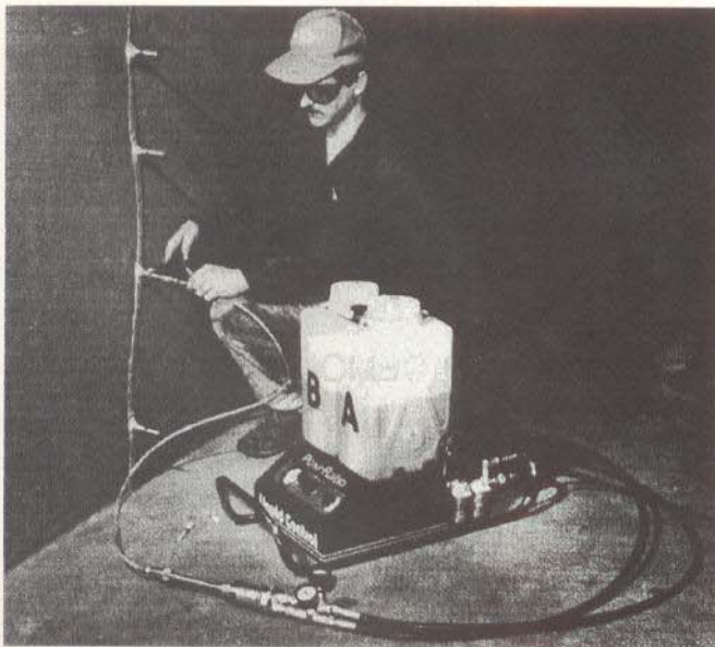
Serviço de injeção com epóxi. Note o equipamento. Trata-se de uma bomba elétrica com reservatório separado para a resina e o endurecedor, onde o contato só é feito após o bico de controle, em pedaço de mangueira especial que executa a mistura.
