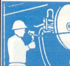
Serra de Muros (Wall Sawing) Até 50cm de esp.
