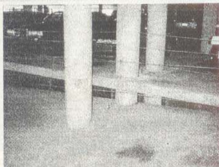
Figura 4 — Pilares flexíveis são a solução para os danos apresentados em pilares curtos e rígidos.
