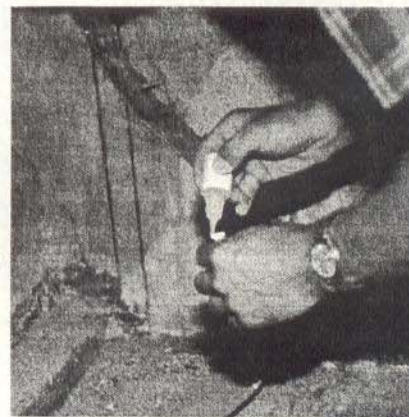
Aplicando-se cola no injetor/purgador.
