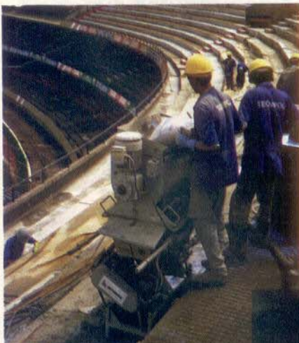
Obra de Recuperação Estádio do Morumbi Janeiro/95
