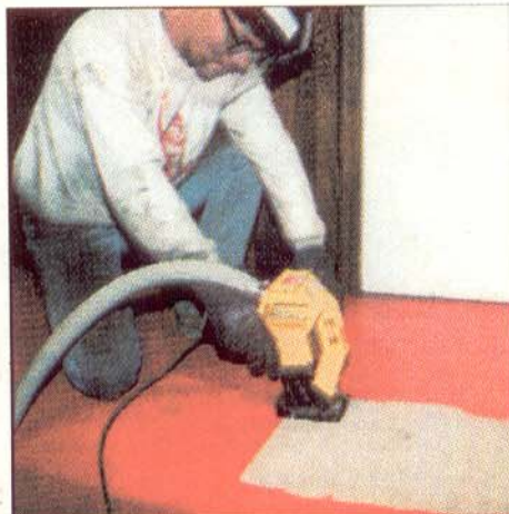
Eliminação do revestimento de um piso
