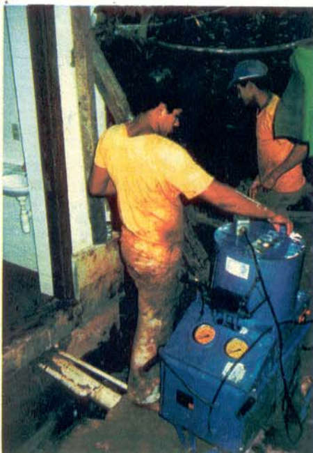
Bomba elétrica para acionamento dos macacos: mais agilidade nos trabalhos
