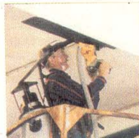
Tratamento de superfícies de vigas de aço
