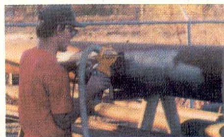
Tubulações de aço e de concreto
