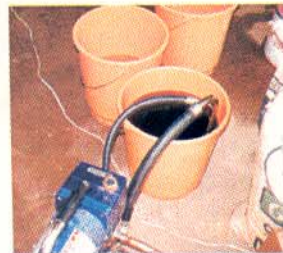
Água com corante para se checar a comunicabilidade entre injetores.
