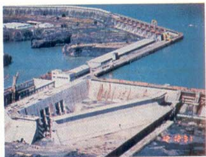
Barragem de cachoeira dourada com 2.000 metros de extensão.
