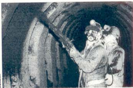
Concretagem das primeiras "janelas" com concreto projetado armado com fibras de aço e sílica-fume. Utilizou-se também plastificantes, redutores d'água e aceleradores de pega.
