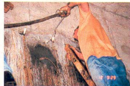
Serviços de injeção de poliuretano.
