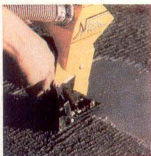
Eliminação de qualquer revestimento em plataformas metálicas
