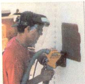
Eliminação da pintura em pontes e tanques de armazenamento de petróleo
