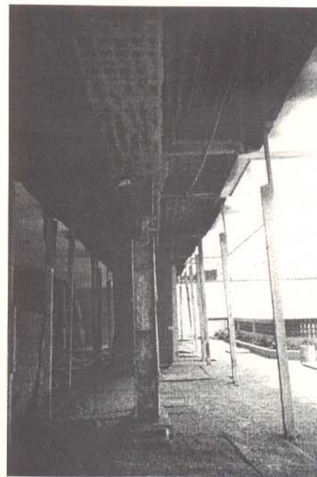
Finalmente iniciaram-se trabalhos de concreto projetado.
