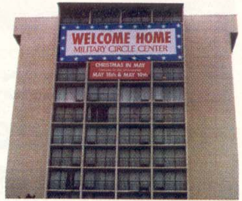
O Sheraton, após os serviços de recuperação e PC em suas varandas
