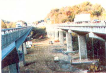
As duas pontes durante os trabalhos de recuperação.
