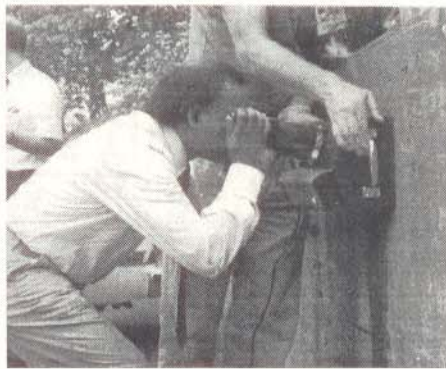
Figura 2: Analizando o concreto com o "equipamento de identificação da R.A.S".
