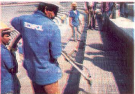
A projeção da argamassa especial.
