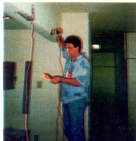
Um sistema simples de semi-pilha com um eletrodo de cobre sulfato de cobre mede o potencial das armaduras nesta viga no interior de um edifício. A norma ASTM C 876 fornece as diretrizes para a execução deste teste.
