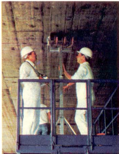
Semi-pilhas conectadas a rodinhas. Este sistema, agiliza sobremaneira o levantamento dos potenciais de corrosão em grandes áreas.
