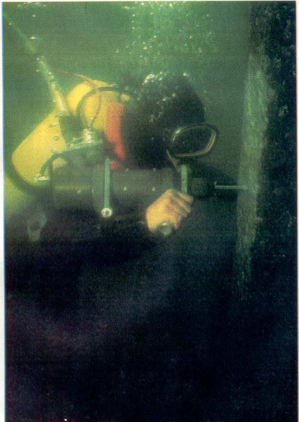
Um mergulhador usa um esclerômetro, adaptado para serviços submersos, para estimar a resistência à compressão do concreto de uma estaca.
