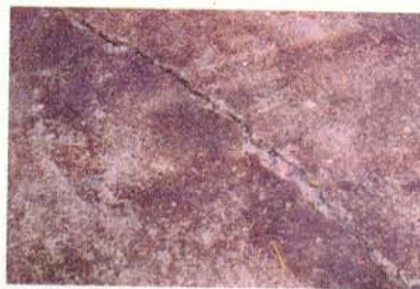
trincas e fissuras, além de juntas com bordas quebradas em pisos de indústrias, aeroportos e garagens. Um problema antigo.
