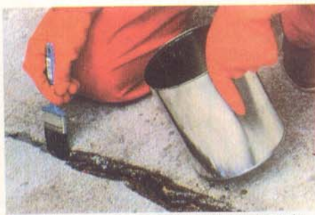
Após o hidrojateamento e a secagem, deverá ser passado um pincel com o metacrilato, de modo a servir de ponte
