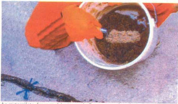
Ao metacrilato deve-se à juntar areia fina e seca, obtendo-se uma argamassa com consistência de "areia de praia molhada".
