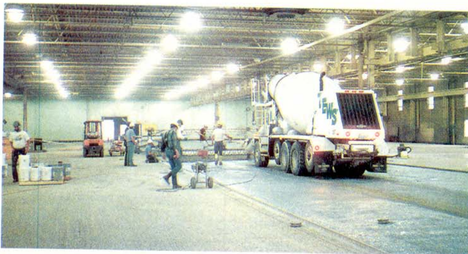
Em pisos industriais, o uso de fibras aliado a modificações no concreto/argamassa, tem a sua melhor utilização.
