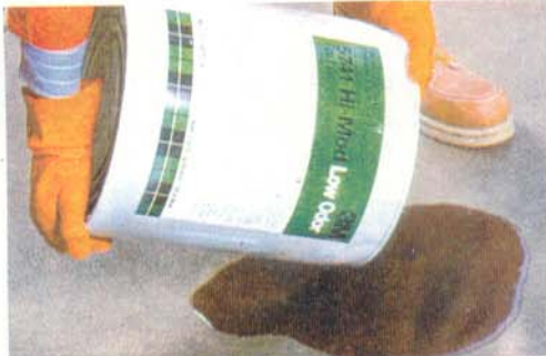
Após a recuperação, verte-se o metacrilato sobre o piso limpo
