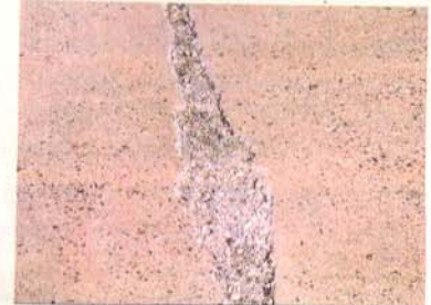
trincas e fissuras, além de juntas com bordas quebradas em pisos de indústrias, aeroportos e garagens. Um problema antigo.
