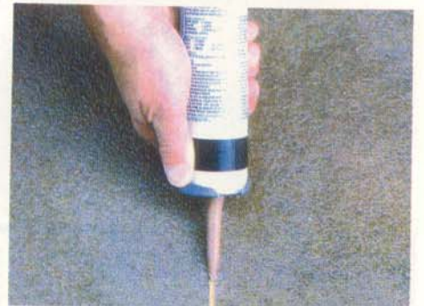
Após o corte, com a redefinição da antiga junta, promove-se o seu calafetamento com um elastômero.
