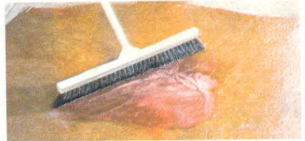
Com um vassourão espalha-se o produto, que por si só fará o trabalho de penetração no piso.
