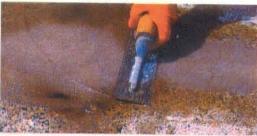
Após o preenchimento faz-se o alisamento com desempenadeira de aço.
