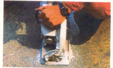
No caso de redefinir a junta, utiliza-se uma serra de corte.
