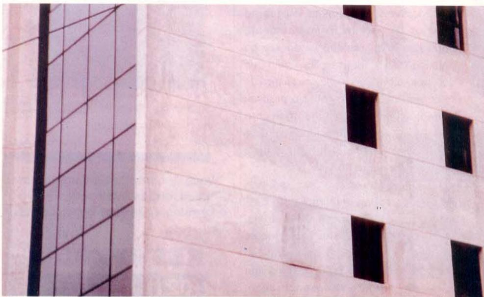
*Foto comparativa. Nota-se nesta fachada que o revestimento de acabamento é absolutamente permeável, fazendo com que as trincas do emboço fiquem completamente expostas à ação da chuva. Verifica-se, perfeitamente, a presença d' água na parede.*
