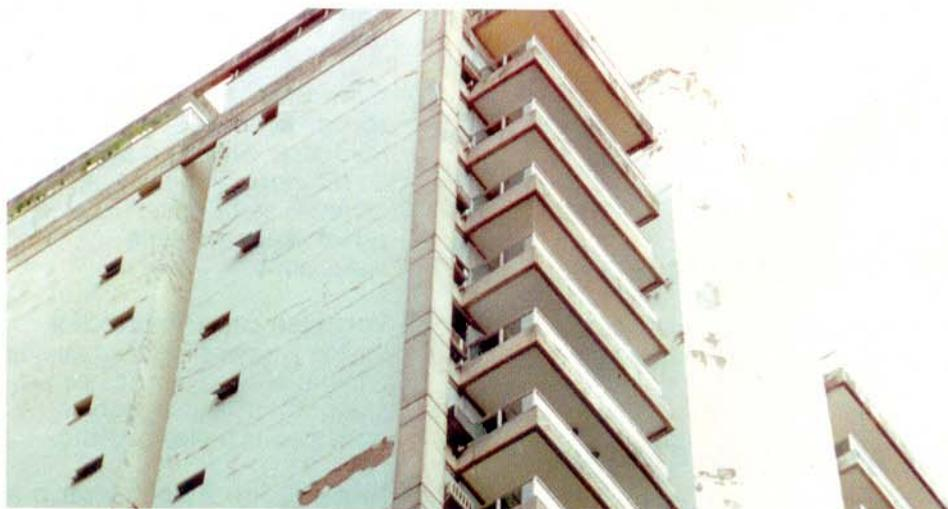
No canto esquerdo da foto verificam-se sérios deslocamentos com a presença de emboço exposto, evidenciando grande quantidade de argila. Nota-se que o sintoma é generalizado. O emprego de tinta, embora acrílica, não significa que resistirá à intempérie. É necessário conhecer sua performance antes de comprá-la. A tinta empregada neste edifício não teve qualidade suficiente para proteger seu emboço suporte.
