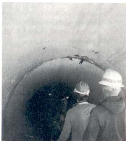
A inspeção na galeria revelou ausência de tratamento adequado nas juntas.
