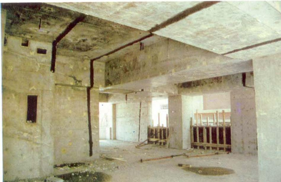
*O finíssimo fio (anodo) de titânio sendo fixado juntamente com uma imprimação da pintura energizante nas paredes e lajes (de concreto armado).*
