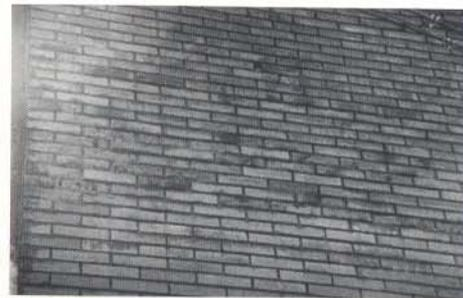
O grau de degradação do revestimento cerâmico, função da ausência de um protetor adequado.
