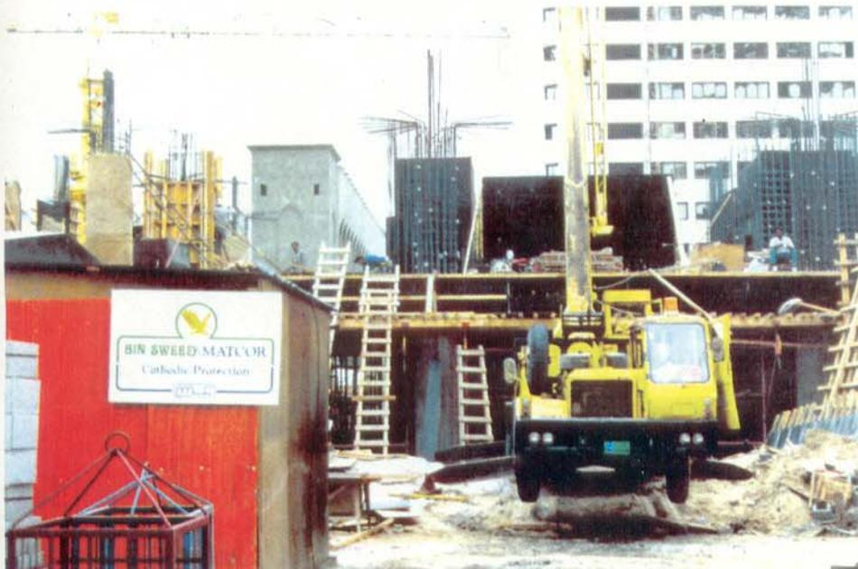
Fundação, térreo e 1º andar já com a pintura energizante. Fim do início do processo de corrosão nas armaduras do concreto.
