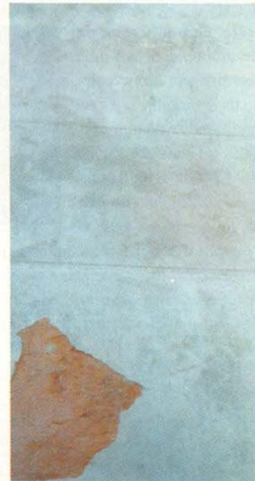
Em detalhe, o estado do emboço entumescido deslocando a própria tinta "protetora".
