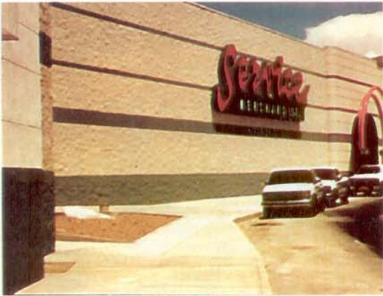
Painéis pré-moldados calafetados com mastique de polisulfeto colorido.
