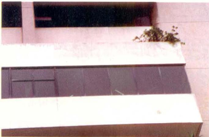
Toda a superfície suporte do emboço, quando comprometida por trincas e fissuras, pode e deve ser protegida por pinturas elastoméricas. Dever-se-á ter cuidado na sua seleção.
