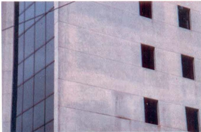
O revestimento aplicado nesta fachada é permeável fazendo com que as trincas do emboço fiquem expostas à ação da chuva. É visível a presença da água no emboço suporte. Por tamanho comprometimento seria ideal a aplicação de uma tinta elastomérica.
