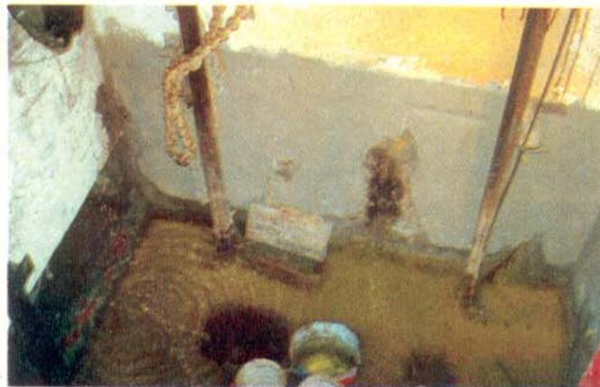
Poço de elevador com minação d'água.
