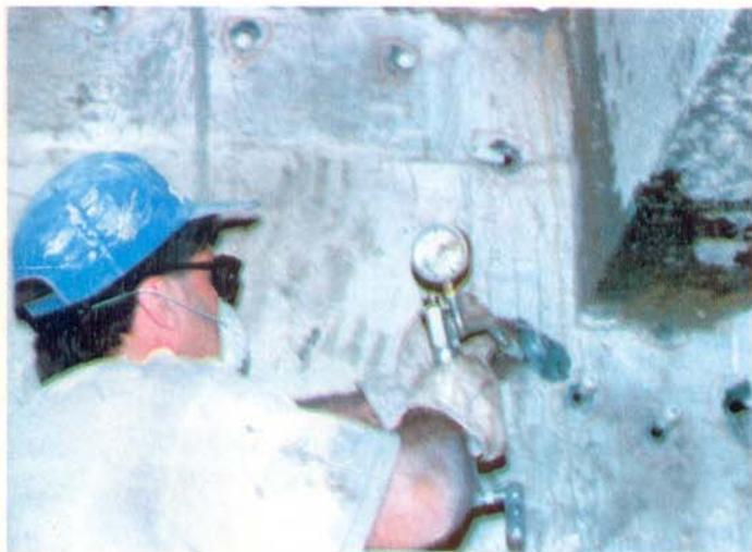
*Injetando PH em parede situada no 3º subsolo de edificação (±10m de profundidade).*
