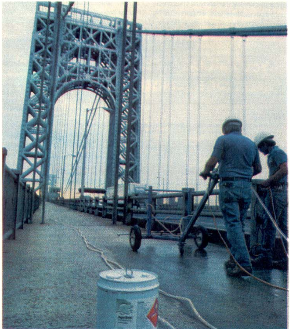
A aplicação de protetores penetrantes é particularmente interessante para áreas externas. Aqui, na ponte George Washington, está se aplicando um silano na passarela de pedestres.
