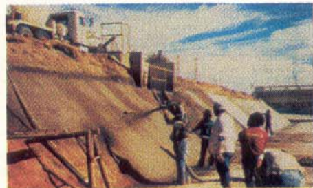
Quilômetros de canais no Arizona foram projetados em concreto armado com fibras sintéticas, de modo a combater a erosão. A adição de fibras sintéticas reduz, drasticamente, a reflexão do projetado e o fissuramento.
