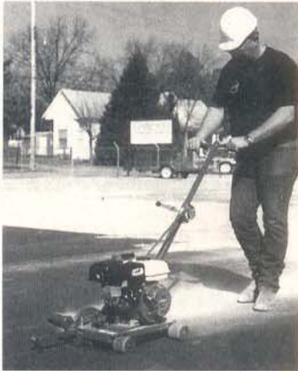
Esta serra, com motor a gasolina HONDA é pequena e bastante eficiente no corte de pisos.
