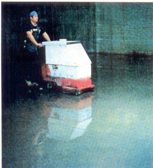
Após a aplicação do líquido endurecedor poderá se dar um polimento adicional
