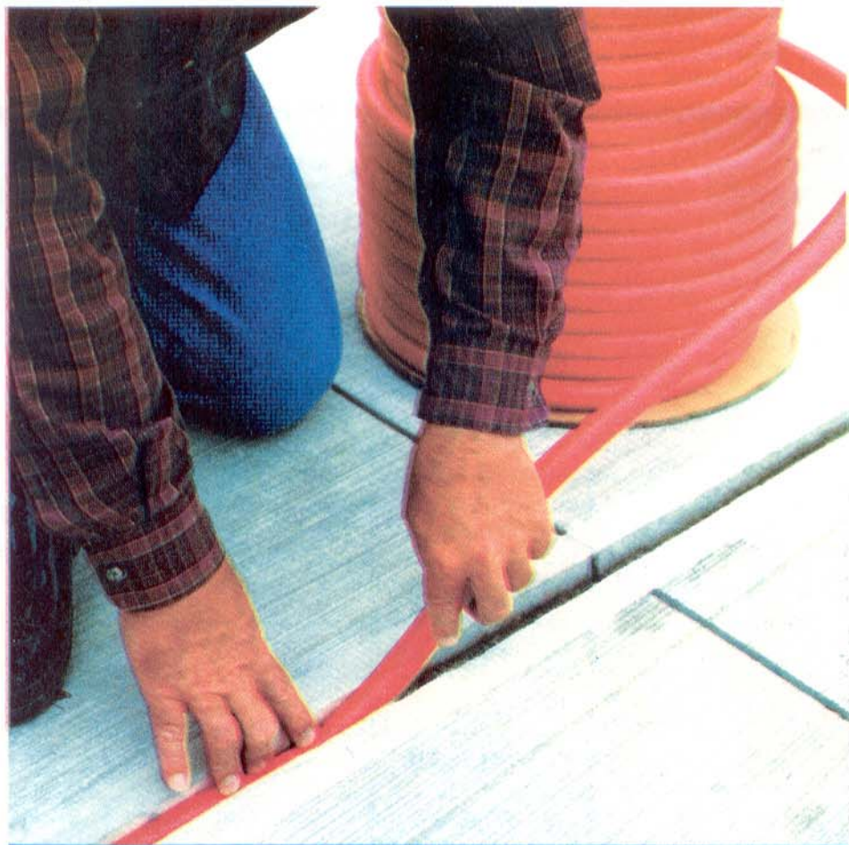
O correto dimensionamento e aplicação do DP é fundamental para a boa performance do mastique.
