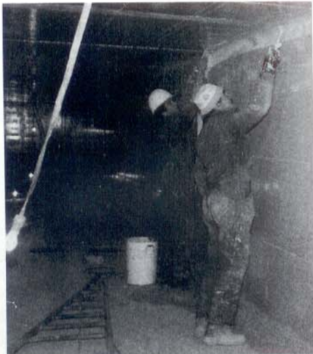
A aplicação de tintas em ambientes parcialmente fechados é bastante prejudicial ao aplicador caso não disponha de equipamento de segurança adequados aos componentes do produto.
