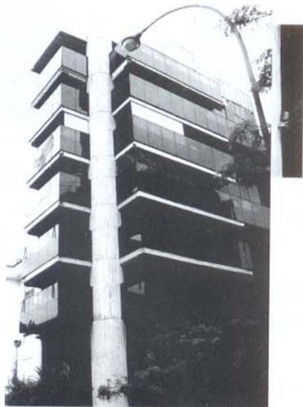
Foto comparativa. Este novíssimo prédio apresenta as juntas do granito com presença d'água. A água da chuva penetra facilmente através do rejuntamento permeável provocando o entumescimento do emboço suporte e mais a frente eflorescências. Na foto acima, em detalhe, uma placa de granito desprende-se.
