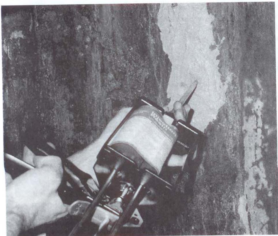
Equipamentos portáteis de injeção e resinas com viscosidade da ordem de 200CPS permitem substituir os caros equipamentos de injeção.
