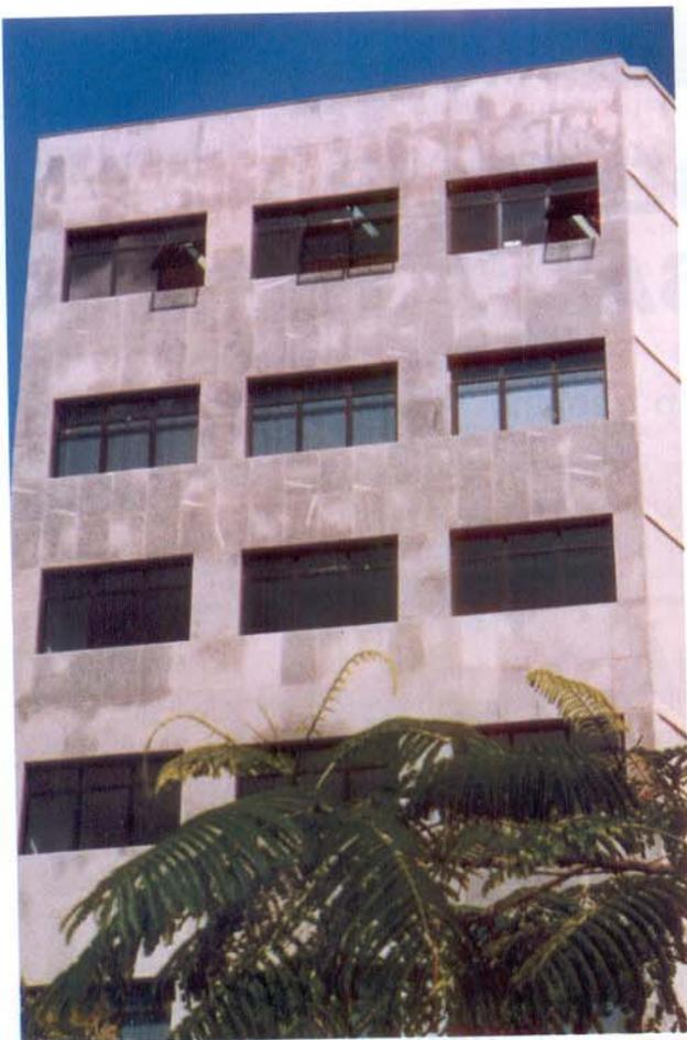
*Também aqui temos a penetração d'água pelo rejuntamento (argamassa), molhando o granito e atingindo as partes internas da edificação.*
