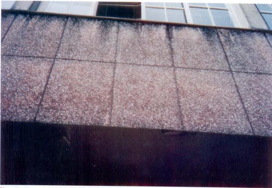
Nota-se neste revestimento, com textura saliente, os efeitos da ausência de proteção contra a ação do tempo.
