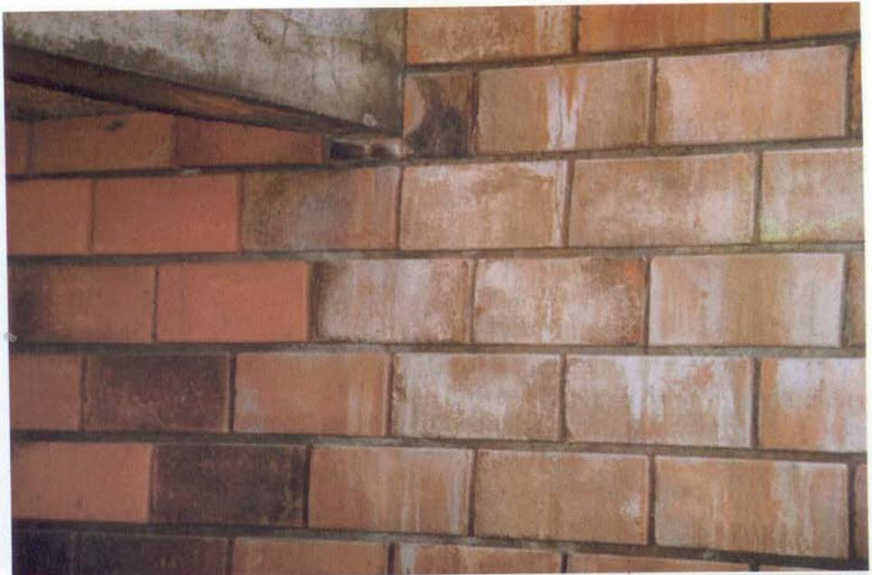
*Neste detalhe verifica-se perfeitamente a diferença entre a cerâmica exposta ao tempo e a protegida. O uso de hidrofugantes é fundamental nestes casos.*
