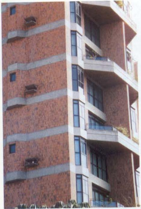
*Nesta edificação cuja fachada é composta por concreto aparente e cerâmica há sérios problemas de penetração de umidade e infiltração d'água para dentro dos apartamentos.*
