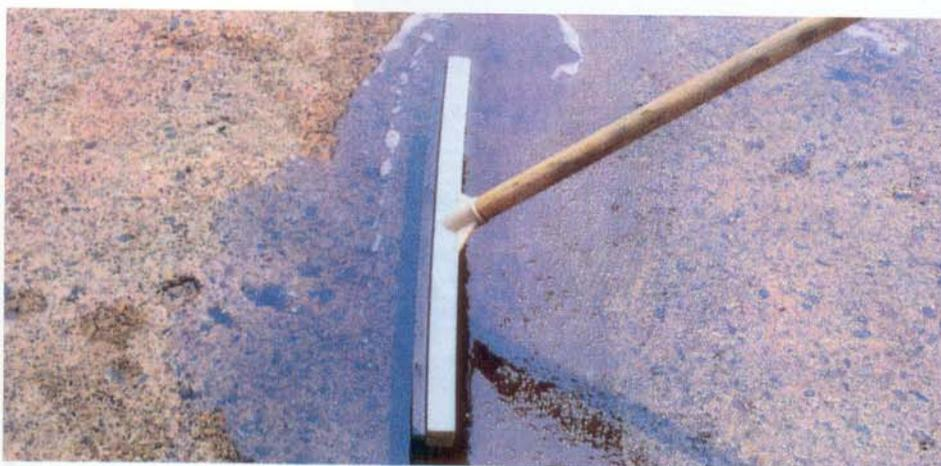
A aplicação do metacrilato sobre pisos e pavimentos preenche fissuras e trinças, causa da maioria dos deslocamentos.
