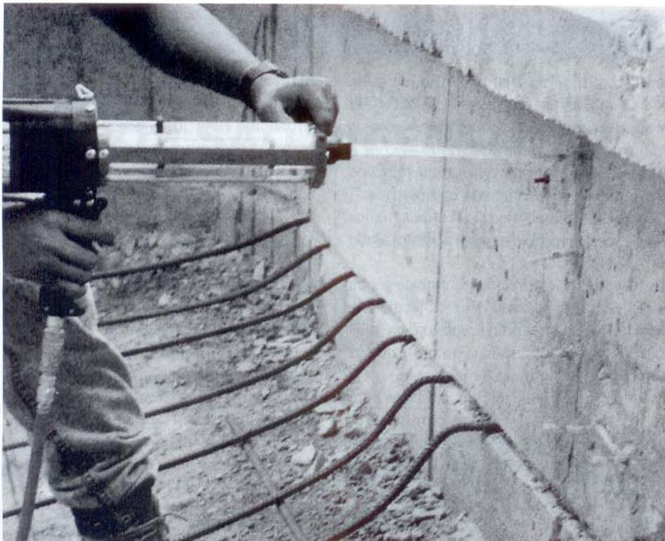
Com epoxi de baixa viscosidade é comum trabalhar-se com sistemas de injeção usando-se misturadores estáticos descartáveis na ponta do equipamento.
