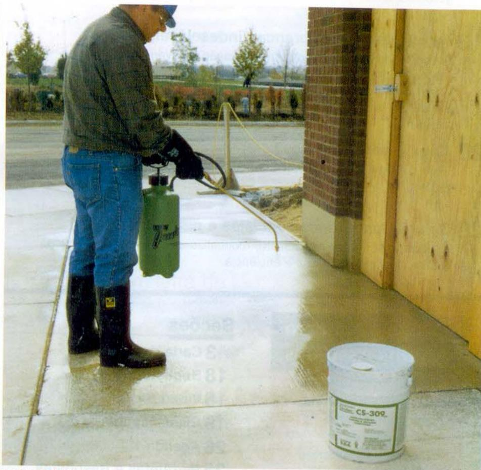
*A aplicação de hidrofugantes em pisos é rápida e fácil com o uso de qualquer tipo de bomba manual de aspersão.*
