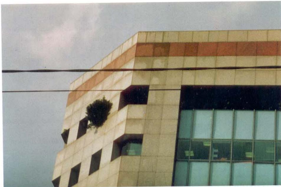
Ausência de rejuntamento adequado faz penetrar água de chuva nas juntas do granito, provocando o encharcamento das pedras pelo seu lado interno. Além da utilização de mastique é sugerido aqui a utilização de hidrofugantes.
