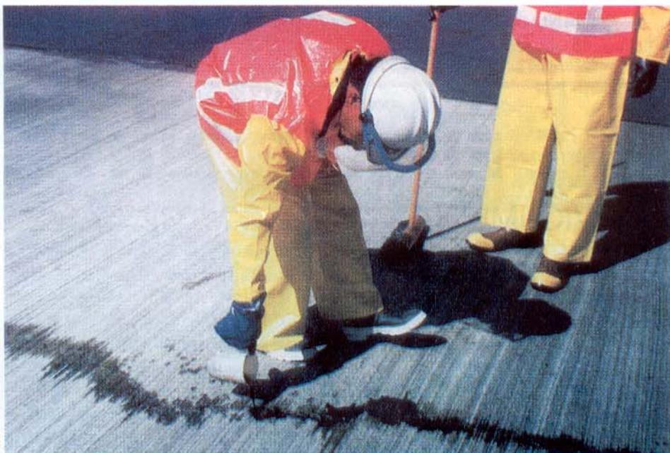
*Trincas em tabuleiros de ponte sendo tratadas com metacrilato. Eficiência e rapidez na obtenção de pequenas fissuras, evitando-se a penetração de agentes corrosivos no interior da peça estrutural, além do monolitismo desejado.*
