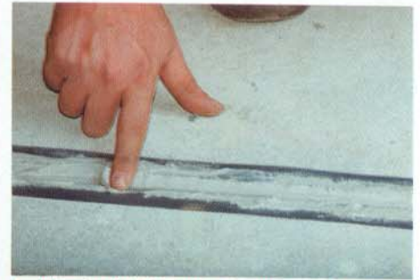
A utilização do dedo, protegido ou não com uma luva de borracha, é muito comum em trabalhos de calafetamento pois permite prensar adequadamente o mastique entre as duas bordas de colagem além de dar o contorno final do acabamento. Repare a importância da fita protetora lateral.
