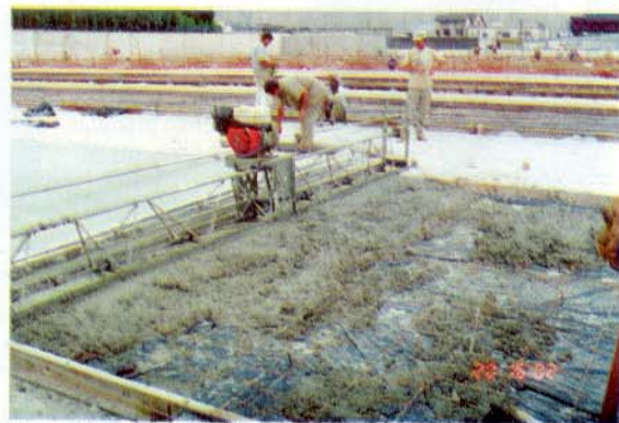
O uso de tela eletrosoldada não é recomendada em função dos benefícios oferecidos pela fibra sintética (ver RECUPERAR nº 7). Repare que o posicionamento original para combater o fissuramento foi alterado, além de proceder à perfuração da lona pelos "caranguejos".
