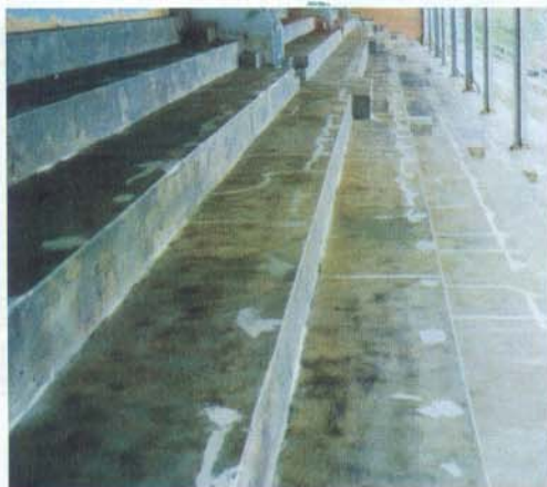
A preparação das superfícies, antes da impermeabilização, é fundamental.
