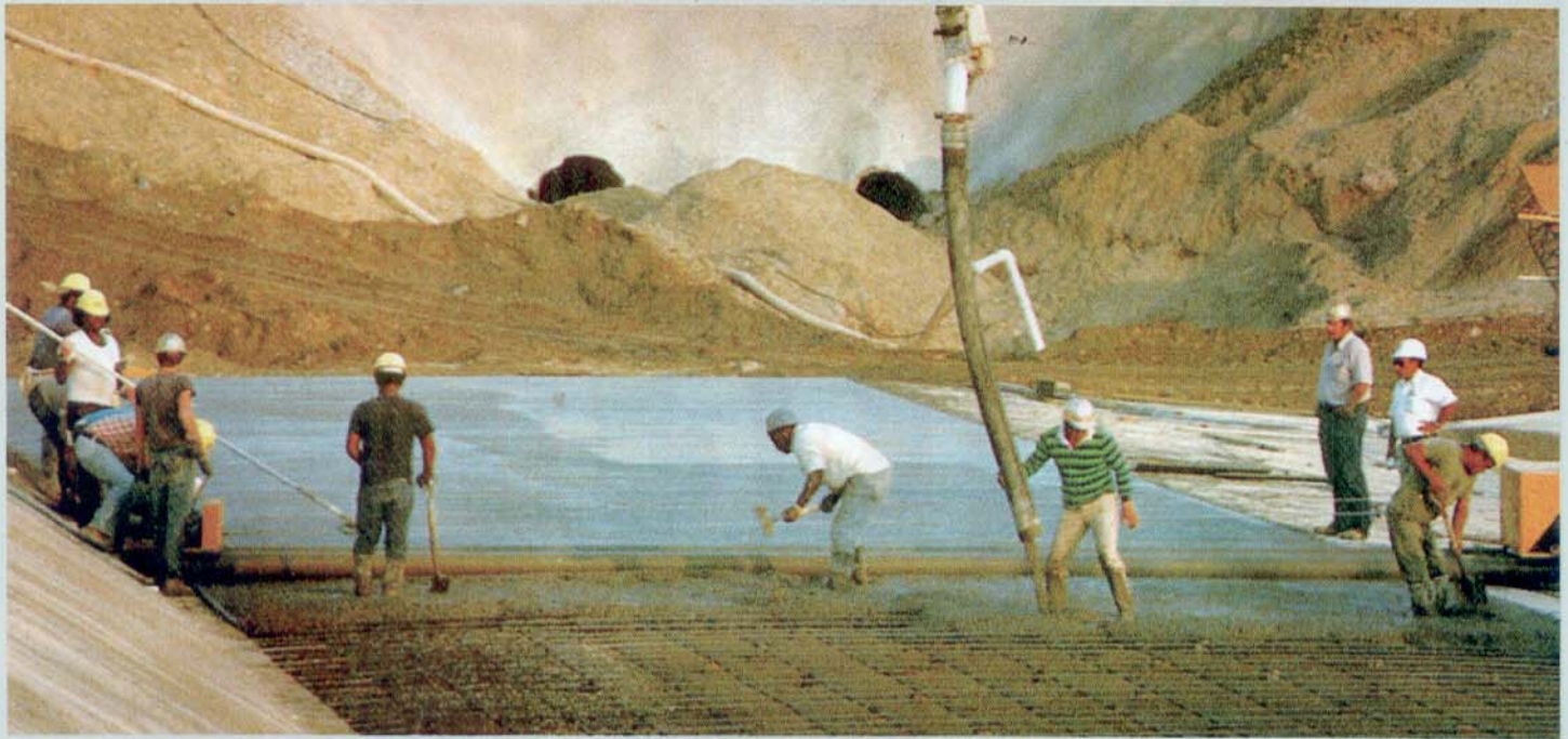
O FLUIFORTE é particularmente indicado para grandes extensões de bombeamento.
