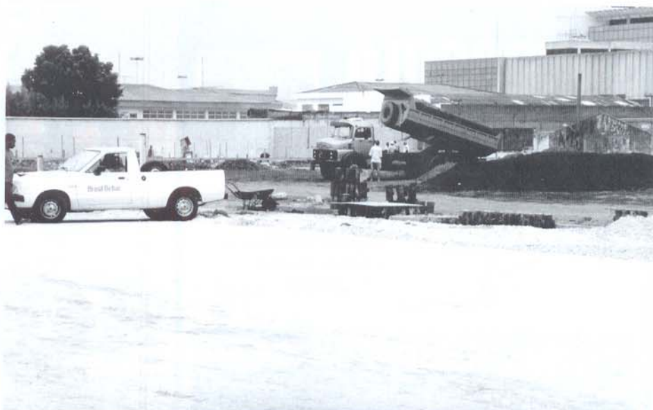
Em primeiro plano vê-se o colchão de material granular (sub base) já preparado para receber o concreto ou a lona. Em segundo plano o material de empréstimo sendo descarregado.
