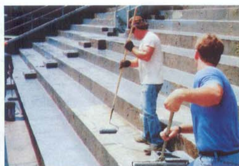
Sua aplicação é muito fácil. Após a limpeza das superfícies é aplicado o primer e a seguir o urepóxi.
