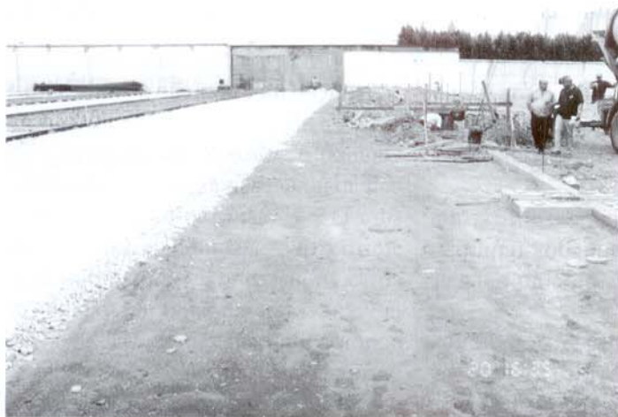
Ao fundo, à esquerda o piso sendo executado em faixas. A sub-base de material granular (brita corrida) e o sub-leito preparado e compactado (material argiloso).
