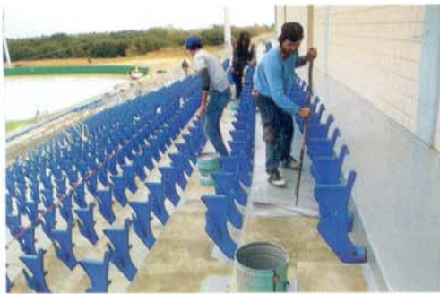
A aplicação do urepóxi é muito simples, necessitando apenas de um primer para preencher os poros e proceder à ancoragem da manta.
