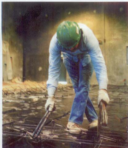
A colocação da lona deve ser cuidadosa. Se possível, sob os apoios em que serão colocadas as barras de transferência, poderá ser colocado algum dispositivo protetor para não permitir a perfuração da lona durante a concretagem.
