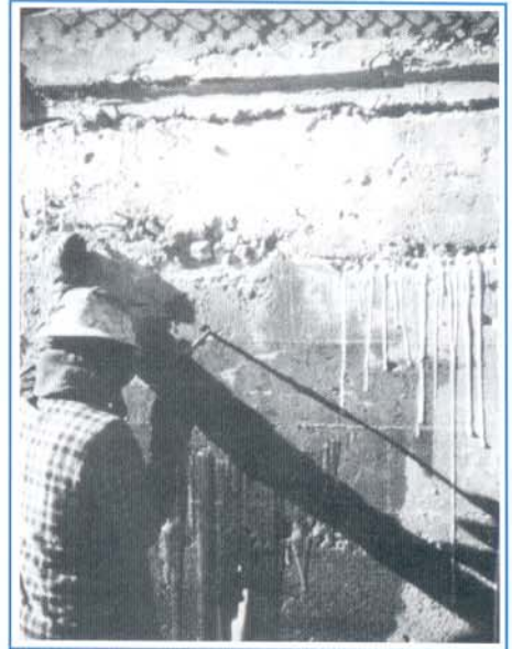
Serviços de injeção na face de jusante.
