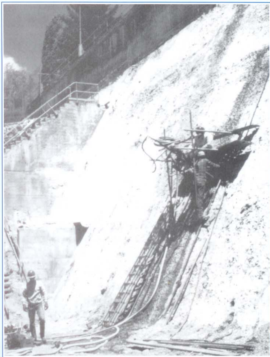
Serviços de injeção de PH flex na face de jusante.
