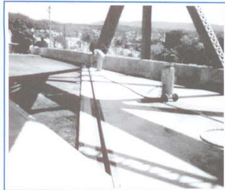
Preparativos que antecedem a instalação da junta de espuma densa.
