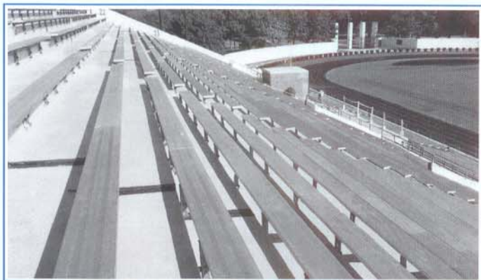
A arquibancada após a impermeabilização
