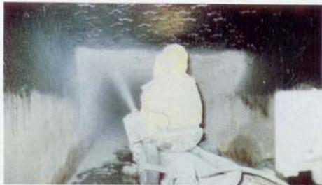
A projeção do micro concreto de silicato de potássio em uma galeria.
