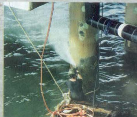
É comum, em trabalhos de recuperação usar-se hidrodemolição ou jateamento de areia (fora d'água) para remover as cracas da superfície do concreto.
