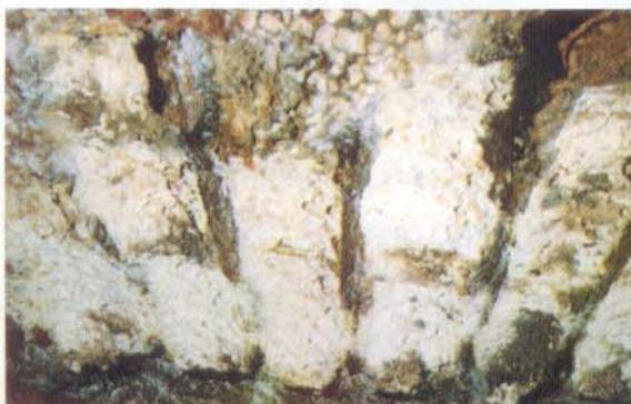
Zona atacada pela CIM. Note a situação das armaduras e, particularmente, a do concreto.
