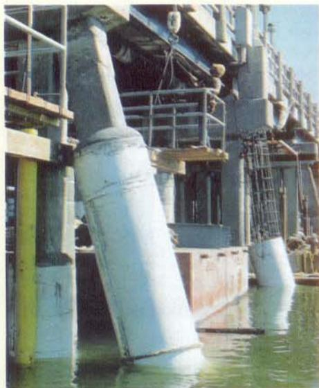
A forma rígida, ao contrário das flexíveis, é fácil de ser instalada em estacas inclinadas. Nesta foto verifica-se que as formas de fibra de vidro foram deixadas no local para servirem de escudo contra a entrada d'água.
