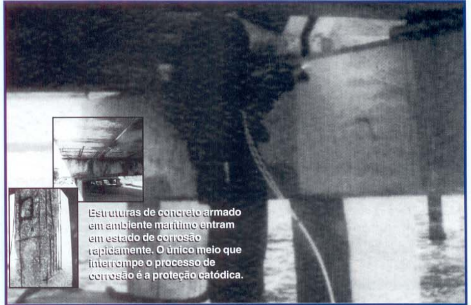
Aplicação de proteção catódica com Zinco Termo Projetado (ZTP) numa travessa de uma ponte.
