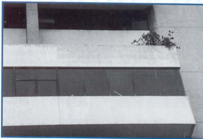
Imperfeições nas superfícies e a rutura do filme da tinta.
