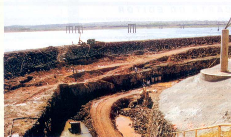
A barragem de Jupiá ao fundo. A enseadeira e, em primeiro plano, a galeria de drenagem da eclusa.
