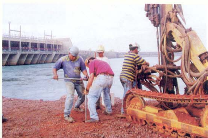
Abertura de rosca na ponta de um trecho de tubo curto. A barragem de Jupia ao fundo.
