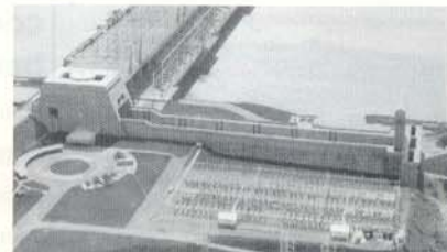
Vista panorâmica da barragem com a eclusa ao centro da foto.
