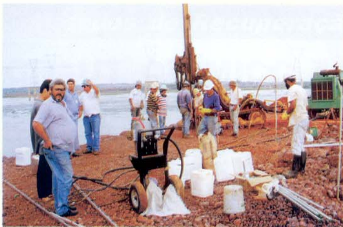
A injeção sendo executada no topo da ensecadeira. Note a pequena bomba pneumática de injeção do graut químico.
