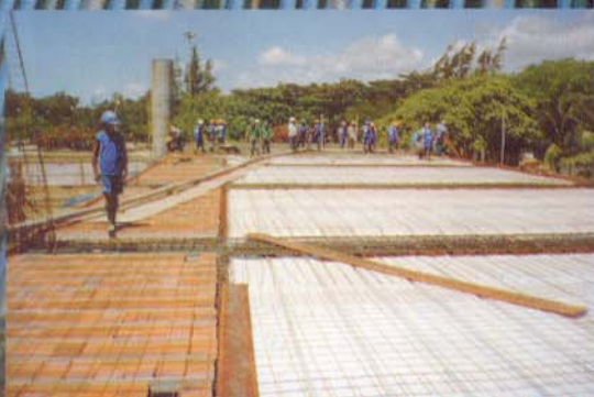
Vista parcial da laje pronta para a concretagem.
