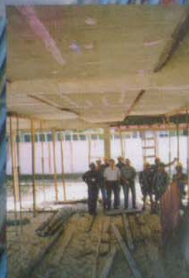
Vista inferior, após a concretagem.
