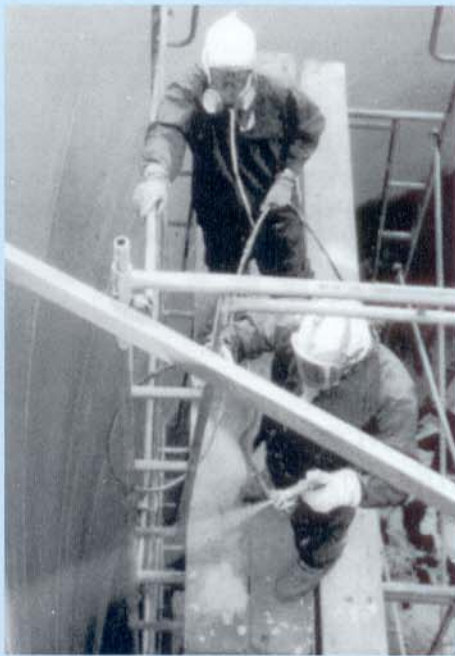
Pintura interna em um silo metálico.
