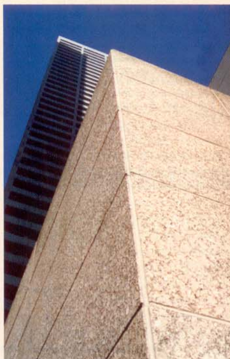
Revestimento em granito com juntas (elastoméricas) entre peças. Esta técnica, aparentemente mais cara, substitui a utilização de juntas entre "panos".
