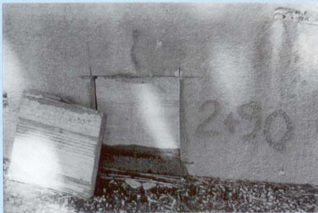
Uma das "janelas" abertas para a inspeção final.
