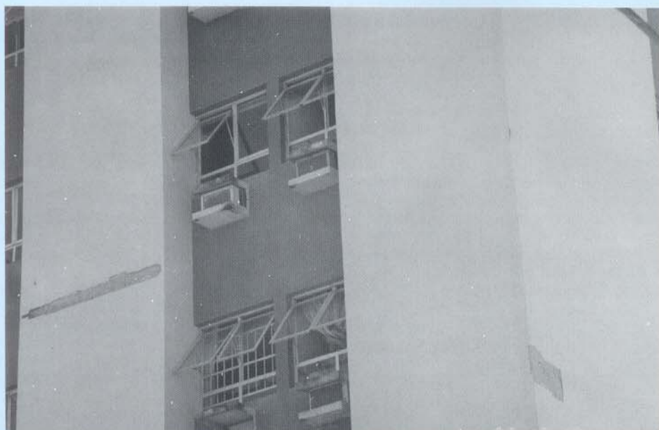
Em detalhes, o revestimento em pastilhas, com processos terminais de deslocamentos e sinais de estufamentos. A ausência de juntas provoca estufamentos e deslocamentos no revestimento.
