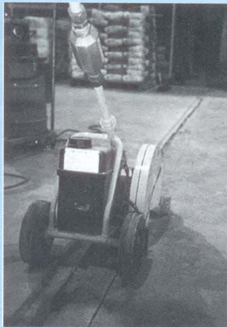
Procedendo o corte no piso.
