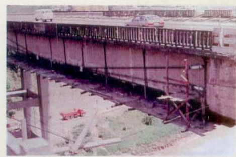
Ponte Guilherme de Almeida, situada na Rodovia Castelo Branco, reforçada com protensão externa. A ponte tem 17,40m de largura e 448m de comprimento.
