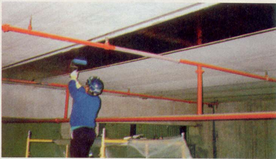
A aplicação do Fibrocarbon-E num fundo de laje...
