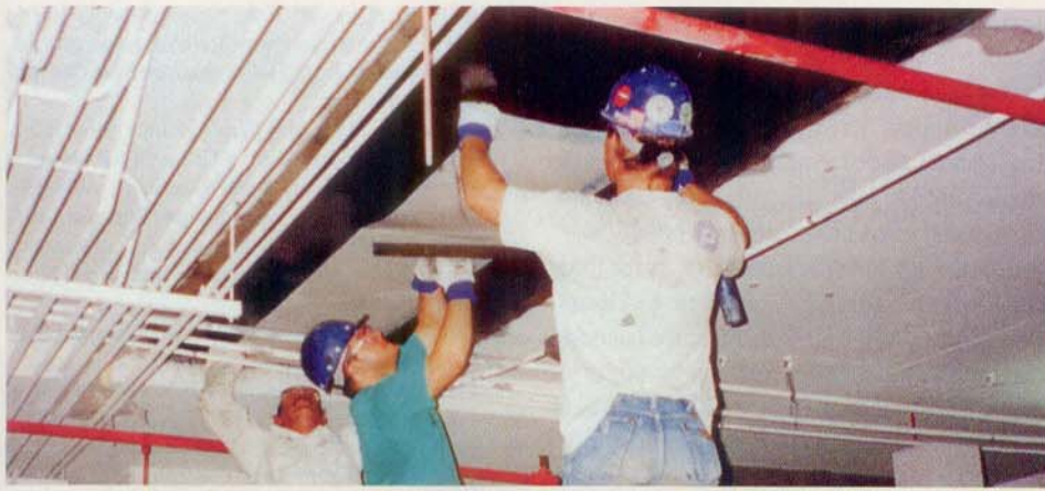
Um trecho de laje sendo reforçada.
