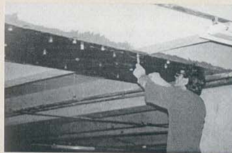
O também tradicional reforço com chapa colada.
