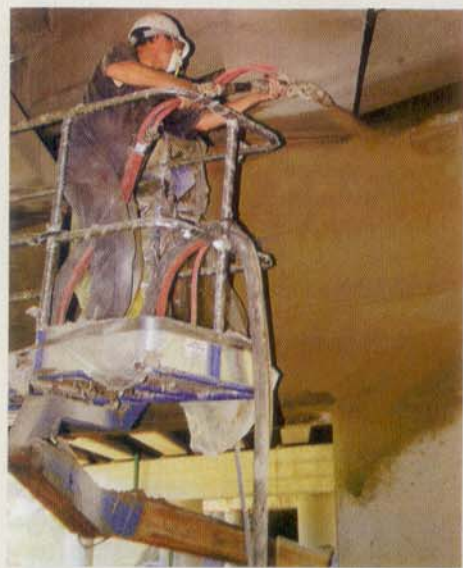
O tradicional reforço com concreto projetado.
