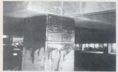
O início do serviço de reforço de um pilar.
