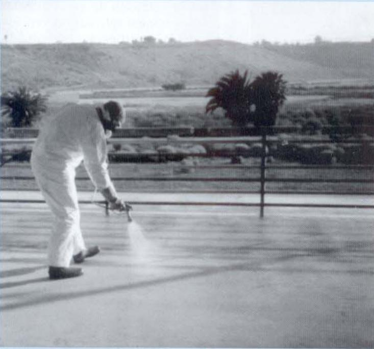
O uso de pintura protetora e impermeabilizante em pisos, vasos e tubulações exige 100% de sólidos na tinta, sem o que, com a fuga dos produtos voláteis haverá furos na película.
