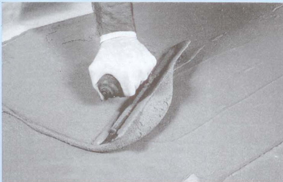
O uso de sistemas aplicados na desempenadeira exige a aplicação de uma película adicional de proteção, colmatando poros e microporos que se formam.
