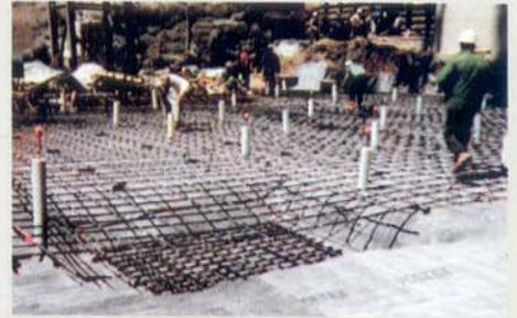
O GIB sendo aplicado como base impermeabilizante, antes da concretagem do piso.
