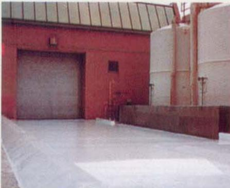
Note que em torno do sistema de estocagem não deve existir qualquer acesso que permita a fuga de produtos tóxicos para o subsolo.
