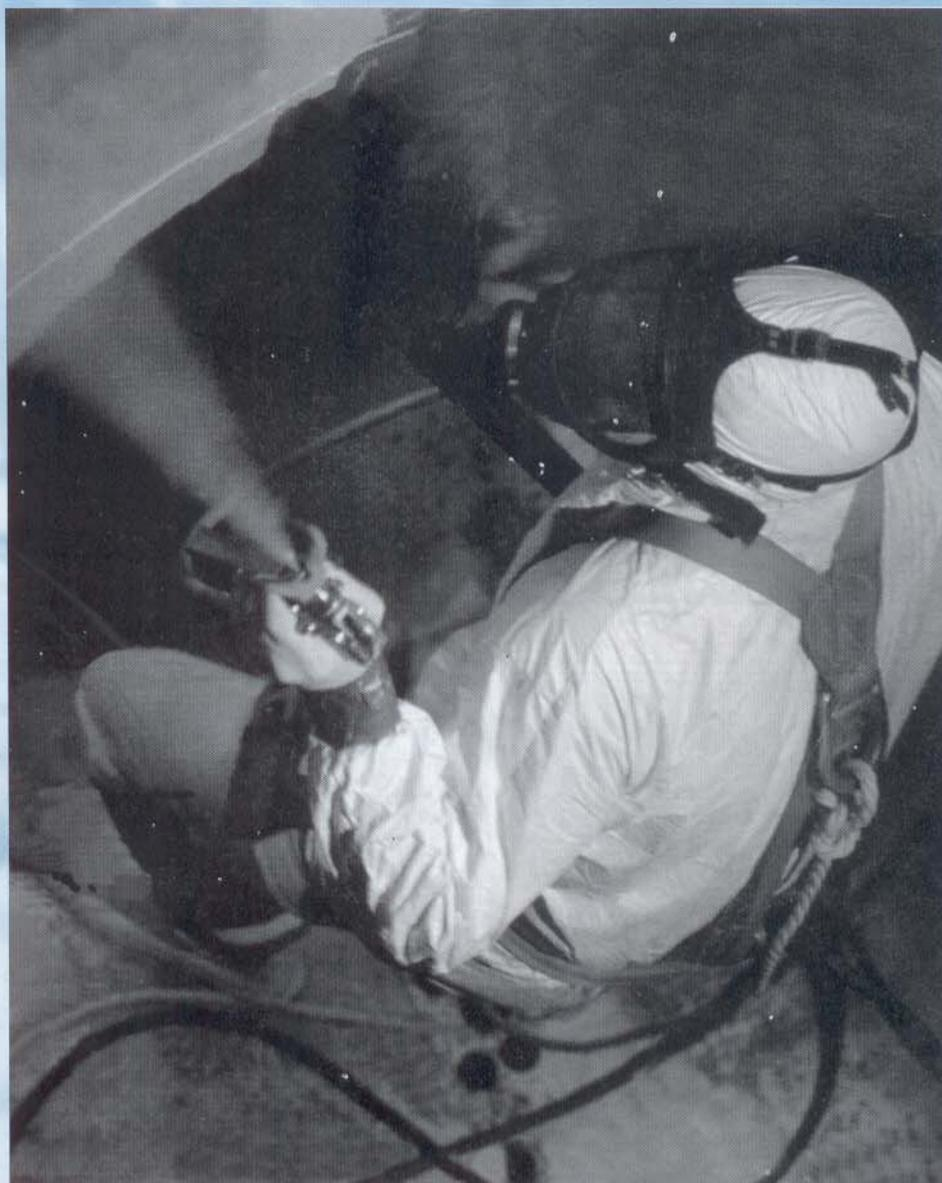
Com toda a ausência de voláteis nas modernas tintas de proteção hoje em uso, a falta de ventilação e o grau de saturação do ambiente, durante o trabalho, impõem o uso de EPI específico. O uso de bomba airless torna-se obrigatório para rendimento do trinômio tinta/mão de obra/prazo de conclusão.
