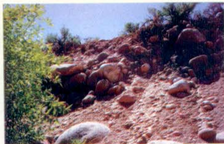
A aspersão do graut químico PH solo promove a aglomeração dos diferentes tamanhos de grãos do solo, inclusive os matações, immobilizando todo o sistema. Ideal para contenção de encostas. Resultados em 24 horas.
