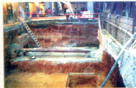
Antes desta escavação foram realizados serviços de injeção de graut químico com o objetivo de impedir o acesso da água freática. Repare que é o interior de uma fábrica de papel.
