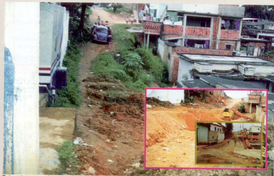
Esta outra rua, na foto maior, tinha como projeto inicial receber uma cortina atirantada que custaria cerca de R$ 170.000,00. Em lugar dela foi feita a estabilização de camadas de solo a cada 30cm com simples aspersão de graut éster silícico e PH solo, compactando-se com um mini rolo compactador. Custo R$ 65.000,00.
