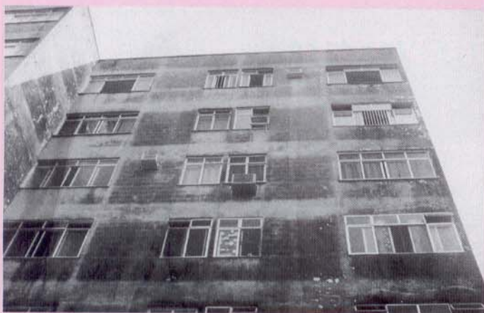
Pintura e emboço absolutamente comprometidos pela instalação de colônias de fungos. A permeabilidade do revestimento e a ausência de proteção específica conduz a fatos como este.
