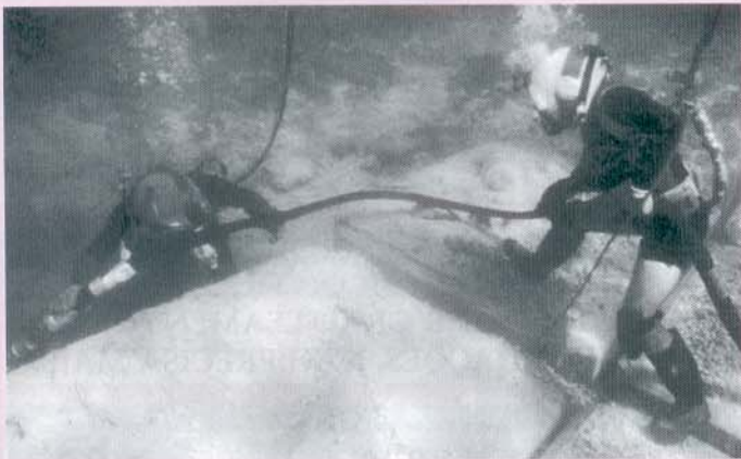
Serviços de grauteamento químico no fundo de uma barragem.
