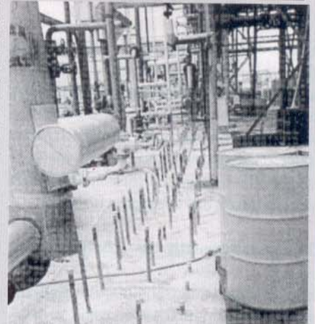
Três linhas de furos, com os tubos de injeção.
