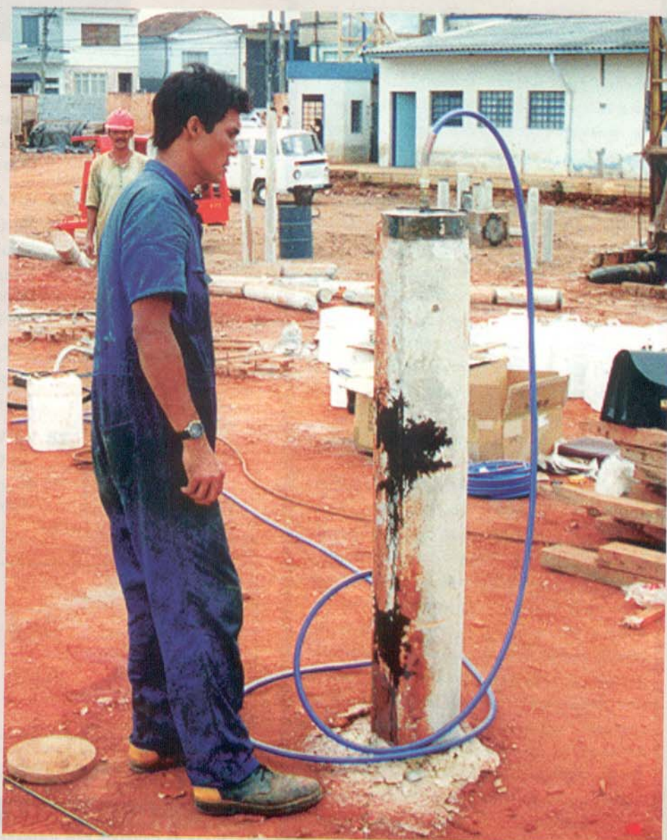
A injeção de grout químico, através de uma estaca teste, provou que é possível duplicar a capacidade de carga grauteando-se apenas a ponta da estaca. O grauteamento lateral aumenta em até dez vezes a capacidade de carga.
