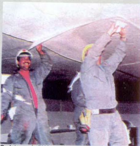
O sistema de PVC sendo aplicado em um digester que apresentava vazamentos e presença de corrosão.
