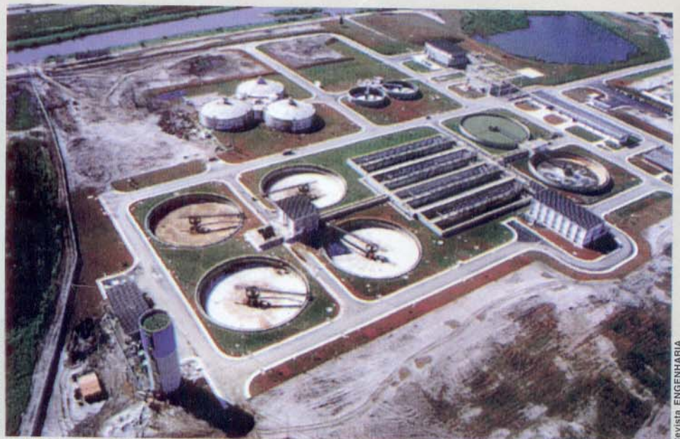
A ETE São Miguel (1.500 litros por segundo) atende o município de Guarulhos e parte da Zona Leste da Capital Paulista.
