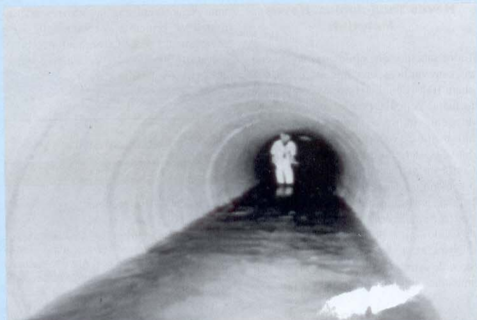
Aplicação do sistema à base de PVC em galerias de esgotos.
