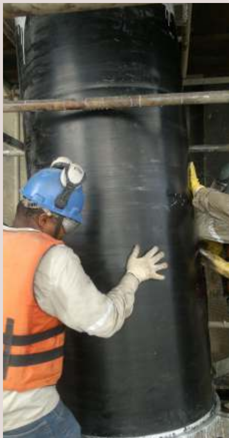
Após a instalação dos anodos é feita a fixação da jaqueta de PEAD de proteção. A jaqueta G é a melhor solução para a interrupção dos processos de corrosão em estacas de pontes e piers marítimos.
