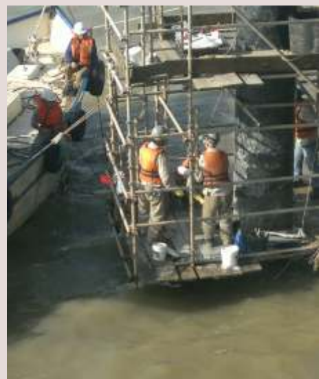
Instalação da JAQUETA G em uma estaca em um porto em São Luís, MA.
