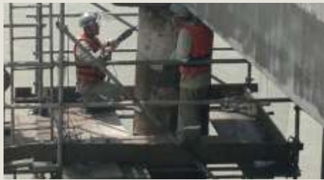
Preparação e limpeza da superfície do concreto e armaduras para entrar com a JAQUETA G.
