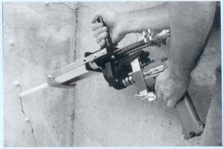
O acionamento dos dois cartuchos aqui é feito com um equipamento movido com uma furadeira alimentada por pilha.
