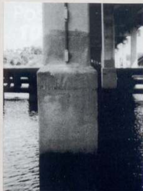
Estacas tratadas com jaqueta G. A pintura preta é de proteção à formação de caracas.
