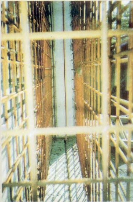
Juntas de construção de reservatórios estão entre as dezenas de aplicações das borrachas expansivas impermeabilizantes de juntas (B.E.I.JU.). Na foto o BEIJU SS aplicado.
