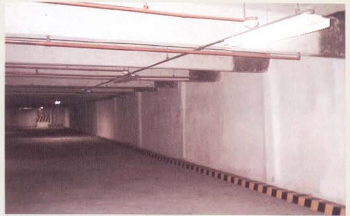
Grande parte do emboço das paredes foi removido, já que encontrava-se totalmente estufado pelo processo de infiltração. Estas fotos mostram duas das paredes após o tratamento com PH Flex, com posterior emboço e pinturas.
