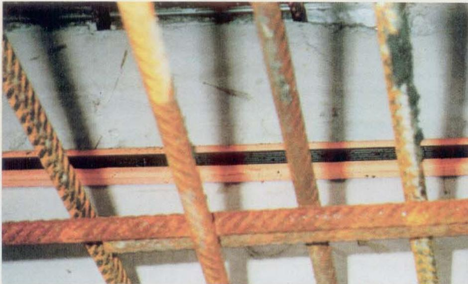
Aqui uma junta de concretagem tratada com o B.E.I.JU. SS. A diferença entre o B.E.I.JU. SS e o S8 está no poder de expansão.
