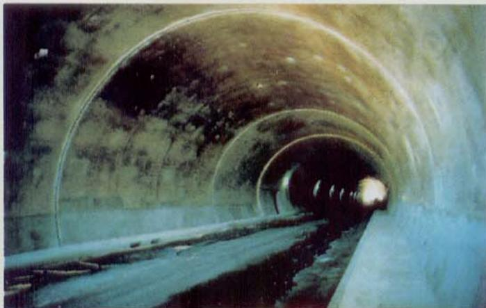
Infiltrações depreciam e causam sérios danos em túneis como curtos circuitos e degeneração de suas paredes.
