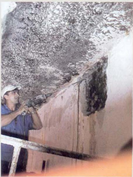
A furação junto à laje. Furando desta maneira acessa-se a zona de engastamento da laje, principal caminho da penetração d'água.
