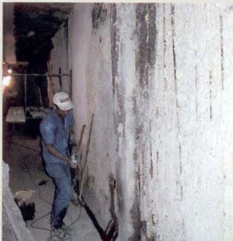
Nas duas últimas paredes, o processo de grauteamento químico foi realizado em três linhas de furos, uma junto ao piso, outra no meio da parede e, finalmente, a terceira junto à laje, com espaçamentos de um metro.
