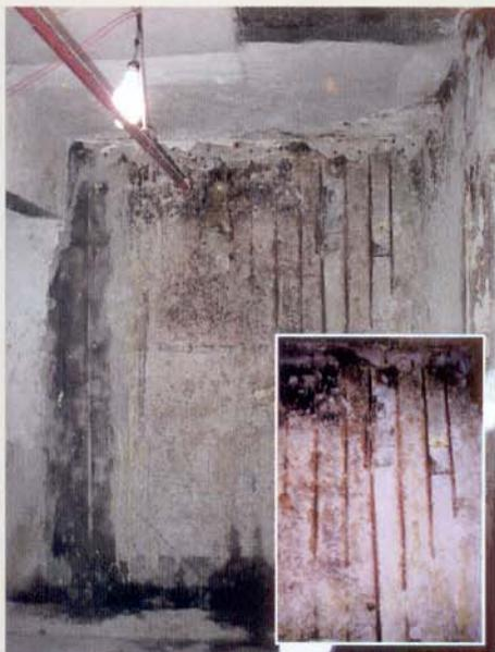
Processo de corrosão provocado pelas infiltrações nas armaduras da parede diafragma.
