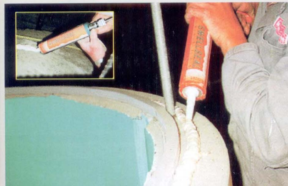
A aplicação do B.E.I.JU. elastomérico é feita um dia antes da concretagem.
