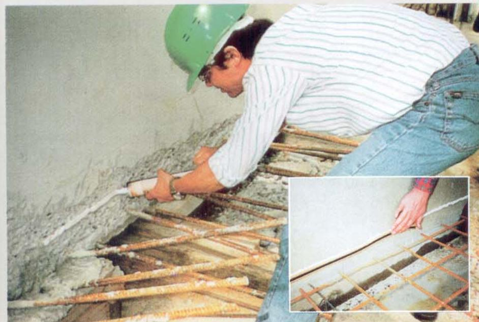
Superfícies irregulares como esta junta de concretagem exigem a aplicação do B.E.I.JU. elastomérico seguido do B.E.I.J.U. SS.
