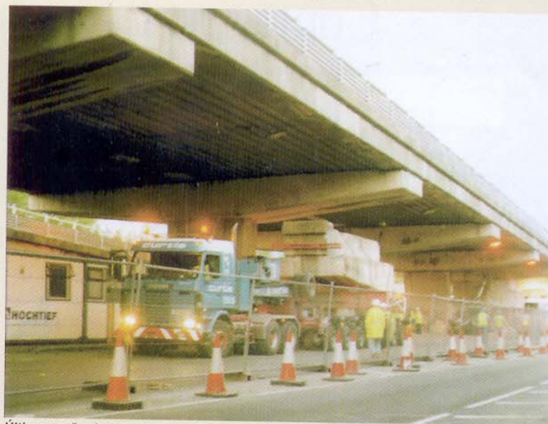
Última seção da travessa sendo transportada.
