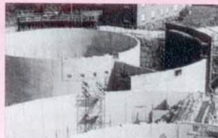
Estações de tratamento de esgotos.
