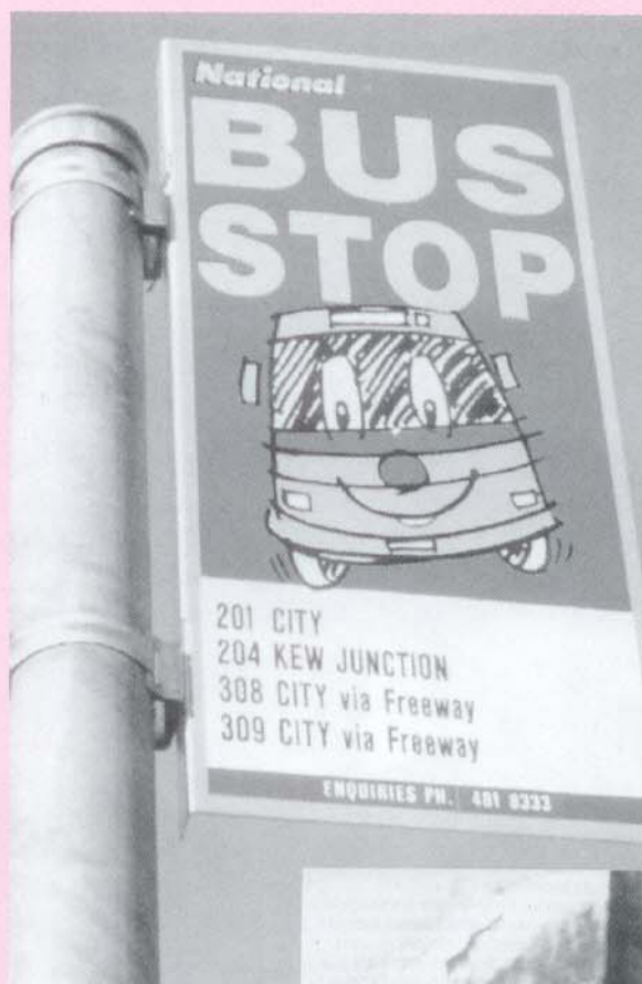
Figura 1 - Uma perfeita combinação de metais diferentes: abraçadeiras de aço inoxidável prendendo um letreiro de aço galvanizado em uma parada de ônibus. O poste é de aço doce.
