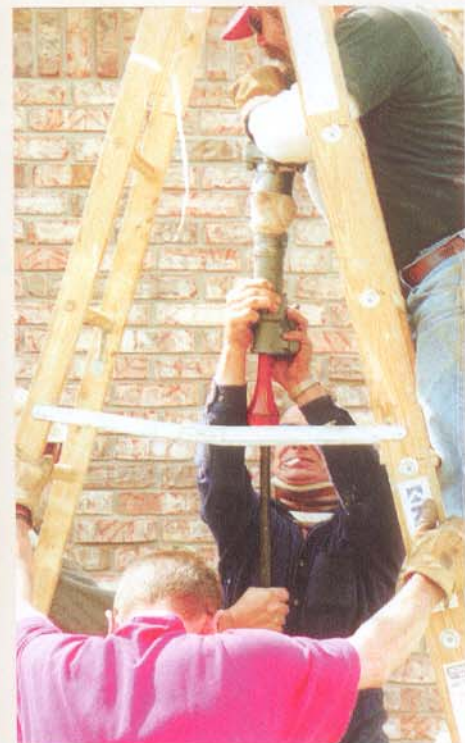
A cravação do tubo poderá ser feita através de um rompedor pneumático com ponta adaptada.
