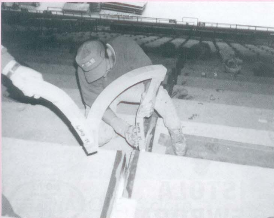
Juntas EVAZOTE sendo instaladas em um estádio de futebol. A tolerância aos inconvenientes das obras é bem maior para esta junta.
