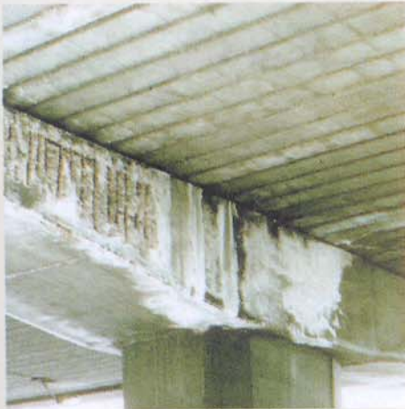
Situação de uma travessa do M4. Semelhança com as travessas de nossos viadutos.
