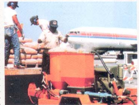
Estabilização do terreno sob a pista de um aeroporto.
