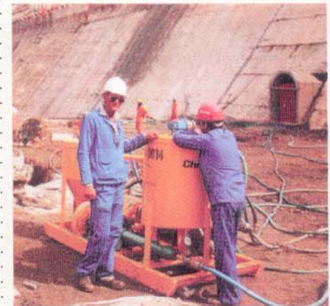
Grauteamento na parede de jusante de uma barragem.
