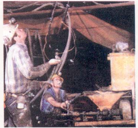
Reforço da estrutura do teto de uma mina.
