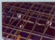
Eletrodo instalado nas armaduras do tabuleiro.
