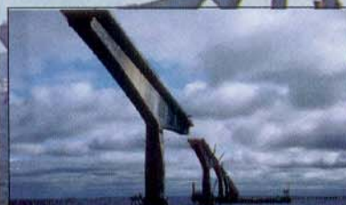
Tabuleiros, travessas e pilares da ponte "Confederação", no Canadá, foram concretadas com eletrodo de prata de modo a se proceder o monitoramento de possíveis processos de corrosão.
