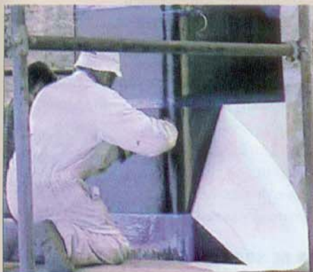
O aumento da resistência à compressão, devido ao confinamento, com o Fibrocarbone. Repare que a seção do pilar é quadrada.
