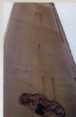
Sérios problemas de corrosão ao longo dos pilares que, certamente não serão tratados de forma eficiente, mais uma vez. Queremos dizer que, novamente serão feitos serviços de "recuperação" sem análise prévia dos sintomas e, efetivamente, permitindo-se que o processo de corrosão se aprofunde cada vez mais, tornando a estrutura cada vez mais "doente".
