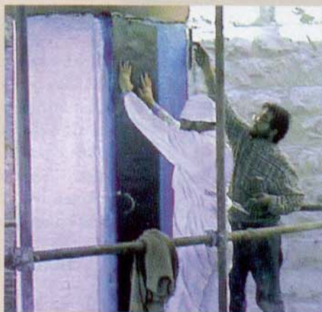
O reforço à flexão com o Fibrocarbone.
