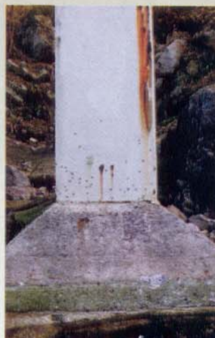
Sérios problemas de corrosão ao longo dos pilares que, certamente não serão tratados de forma eficiente, mais uma vez. Queremos dizer que, novamente serão feitos serviços de "recuperação" sem análise prévia dos sintomas e, efetivamente, permitindo-se que o processo de corrosão se aprofunde cada vez mais, tornando a estrutura cada vez mais "doente".
