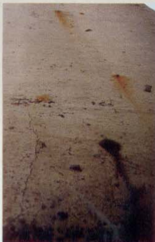
Sérios problemas de corrosão ao longo dos pilares que, certamente não serão tratados de forma eficiente, mais uma vez. Queremos dizer que, novamente serão feitos serviços de "recuperação" sem análise prévia dos sintomas e, efetivamente, permitindo-se que o processo de corrosão se aprofunde cada vez mais, tornando a estrutura cada vez mais "doente".
