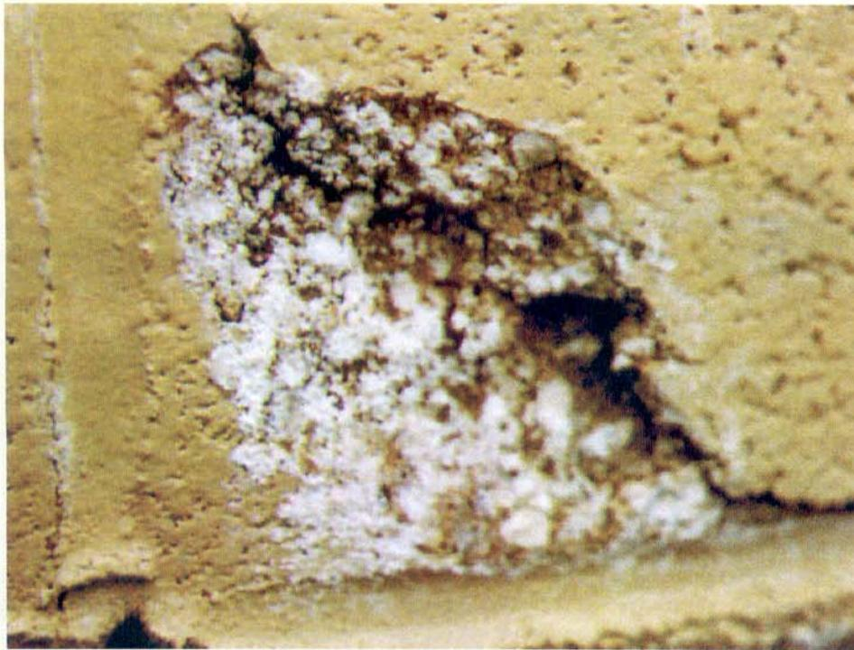
Fenômeno da criptoflorescência causando deslocamento em uma parede de blocos de concreto.
