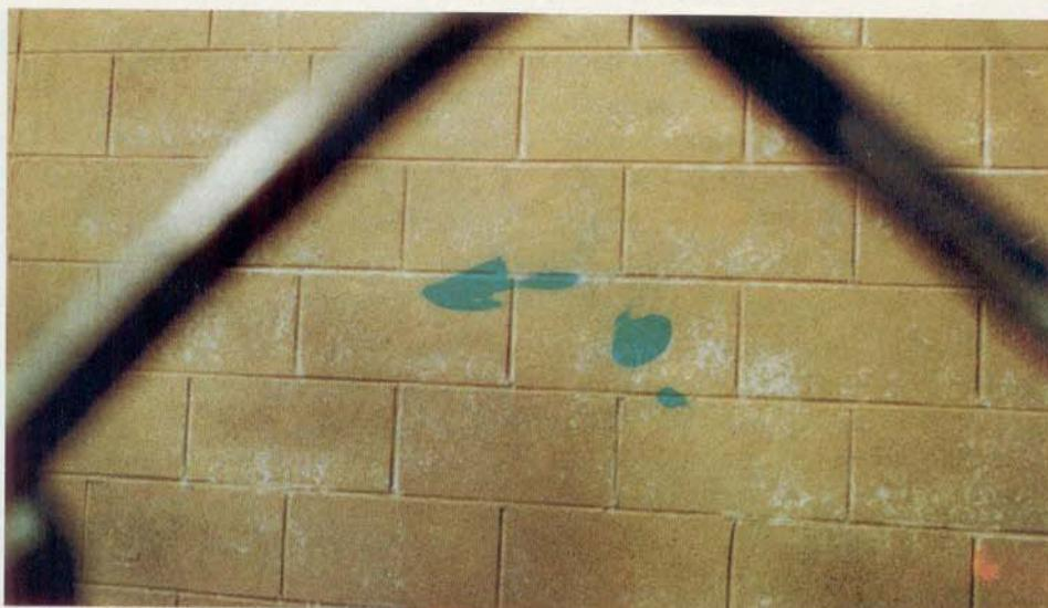
Figura 4 - Tinta permeável aplicada sobre cerâmica exposta ao tempo. Note as eflorescências que migram pelos poros da tinta.
