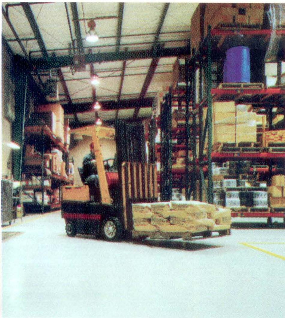
Pisos epóxicos ainda são as melhores alternativas de proteção da superfície do concreto à ação abrasiva da roda de empilhadeiras.
