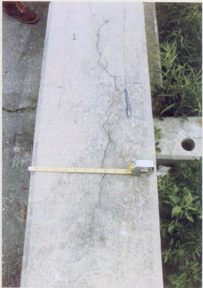
Trincas longitudinais, efeito da RAS, ao longo desta parede. Repare a presença de uma rede de trincas na superfície anexa à trinca principal.
