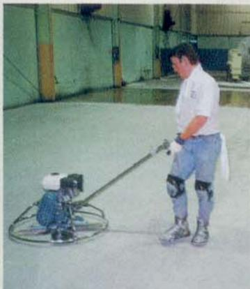
Revestimentos epóxicos exigem o uso de alisadores mecânicos (bambolês)...
