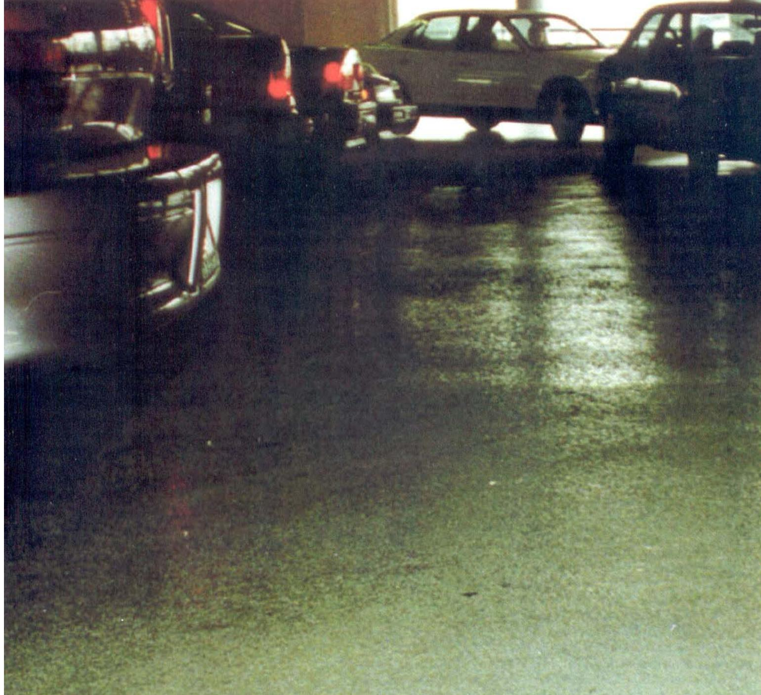
É indiscutível a durabilidade dos sistemas epóxicos para pisos de garagens. O uso de primers epóxicos com baixíssima viscosidade é fundamental para o sucesso do serviço.
