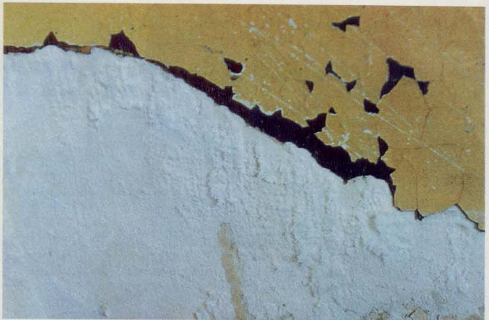
Figura 3 - Deterioração de um velho reboco sob uma película de tinta como consequência da permeabilidade do filme. O resultado é o esfarelamento do reboco acompanhado da ruína da película de tinta.
