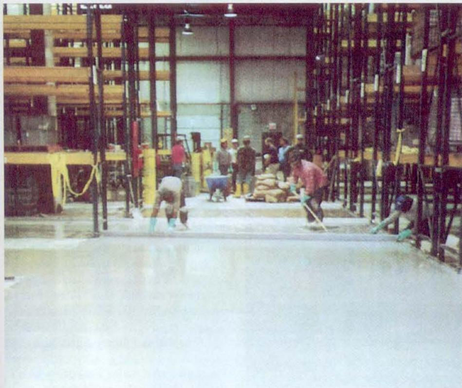
A especificação adequada do sistema epóxico, a análise físico-química do concreto, a preparação das superfícies subdivididas na limpeza e imprimação respondem, juntas, por 50% da qualidade da obra.
