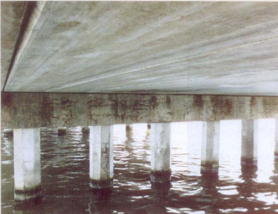
Trincas horizontais ao longo de uma travessa de um pier. Os sintomas da RAS só são corretamente confirmados com a utilização de testes feitos no local ou em laboratório.
