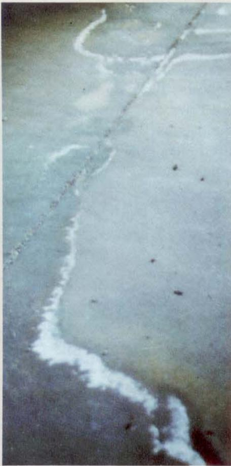
Figura 5 - Piso de concreto com formação de eflorescências através de sua cadeia de poros, trincas, junta de dilatação e juntas frias.
