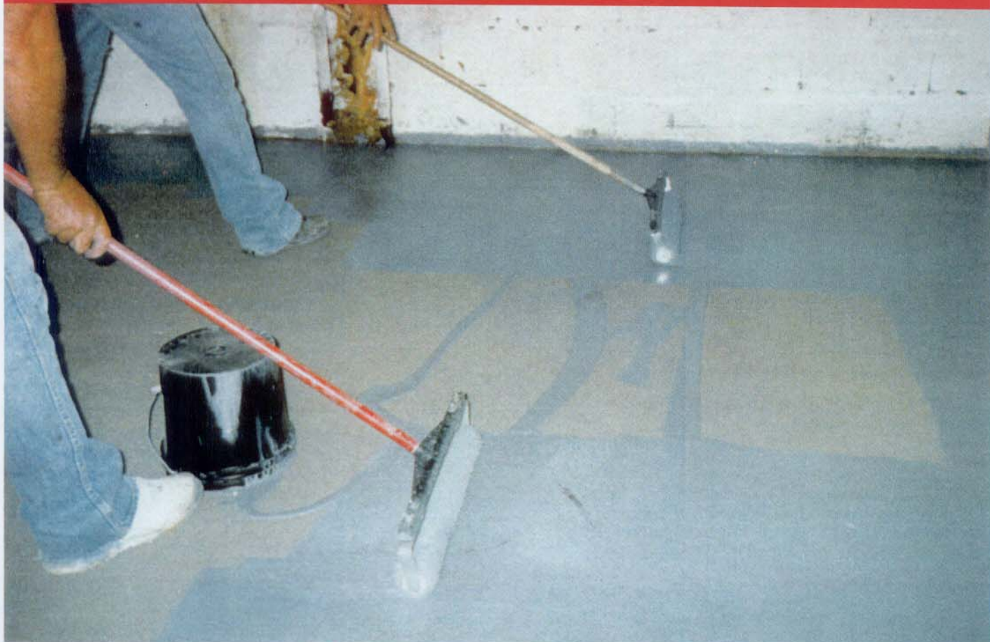
A aplicação de primers com baixíssima viscosidade é fundamental para a eliminação de uma série de problemas durante e após a aplicação do sistema epóxico de acabamento.
