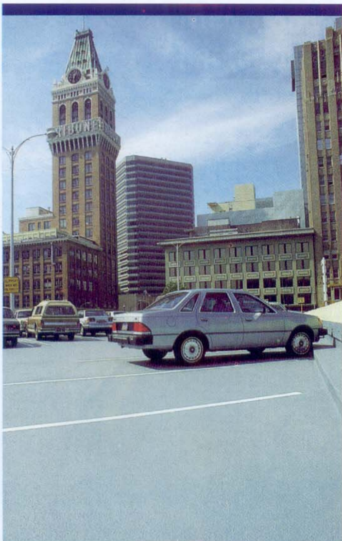
Pisos epóxicos externos. Atenção redobrada na investigação da umidade por transmissão do vapor d'água.
