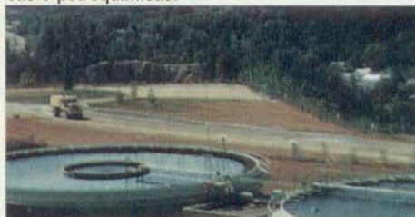
Revestindo o concreto de estações de tratamento de esgotos.
