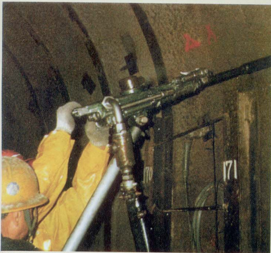
Os serviços de furação da capa de concreto foram feitos por meio de perfuratrizes pneumáticas.
