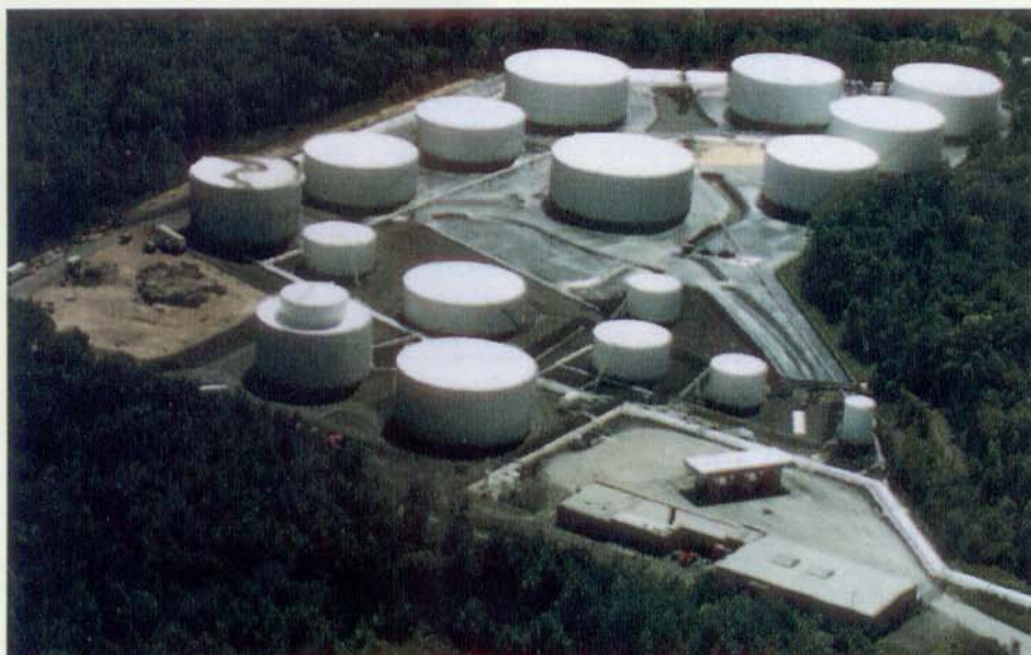
Visão panorâmica de uma indústria petroquímica protegida com estocagem secundária feita com epóxi de alcatrão.
