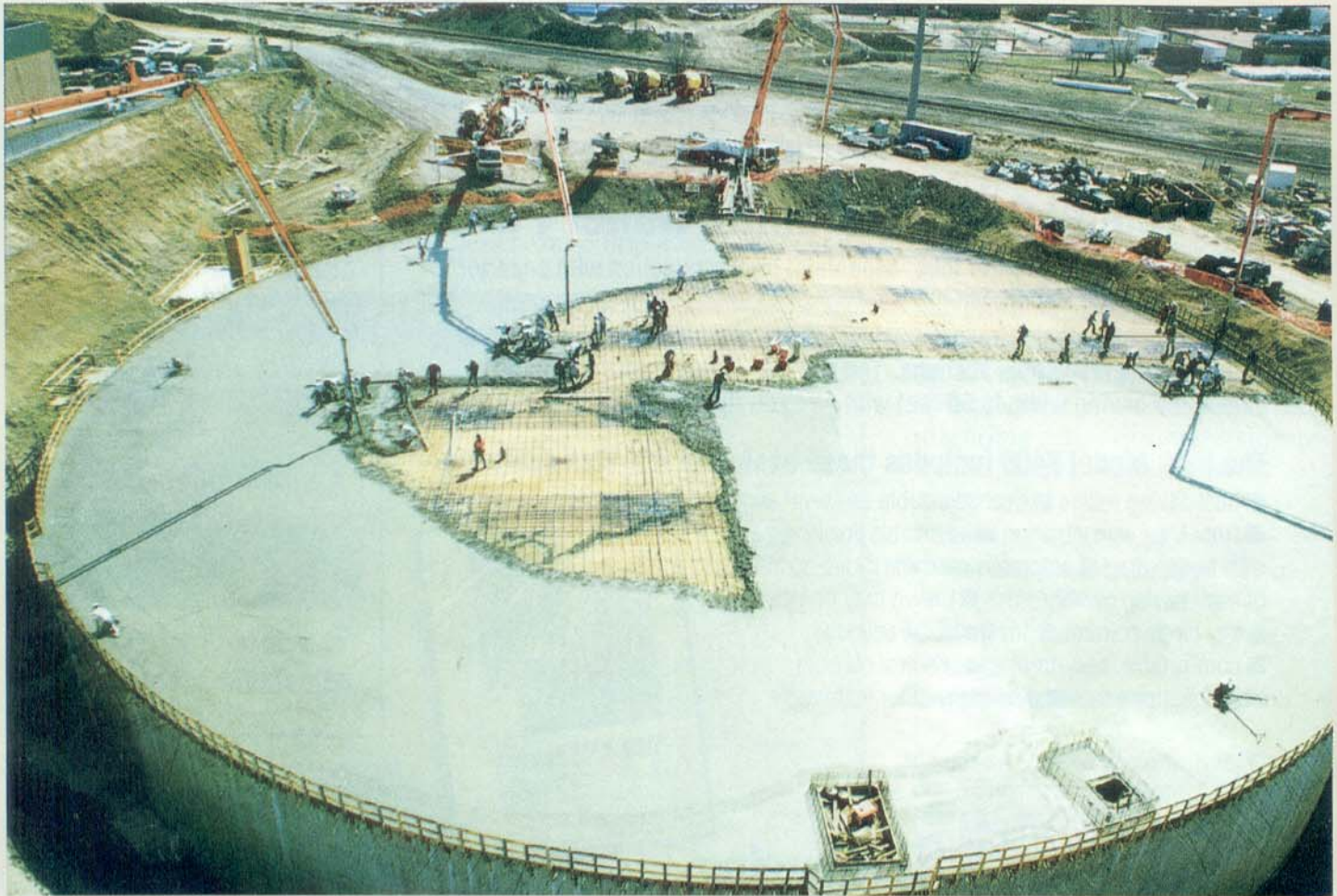
Com quatro bombas, cerca de 35 caminhões betoneiras por hora e uma grande quantidade de operários dando acabamento é possível executar esta laje com 65m de diâmetro em menos de 5 horas. A fibra sintética é essencial.
