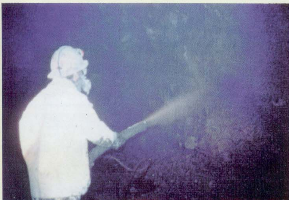
O uso de fibras sintéticas em concreto projetado é feito adequadamente com fibras curtas e pré-torcidas.
