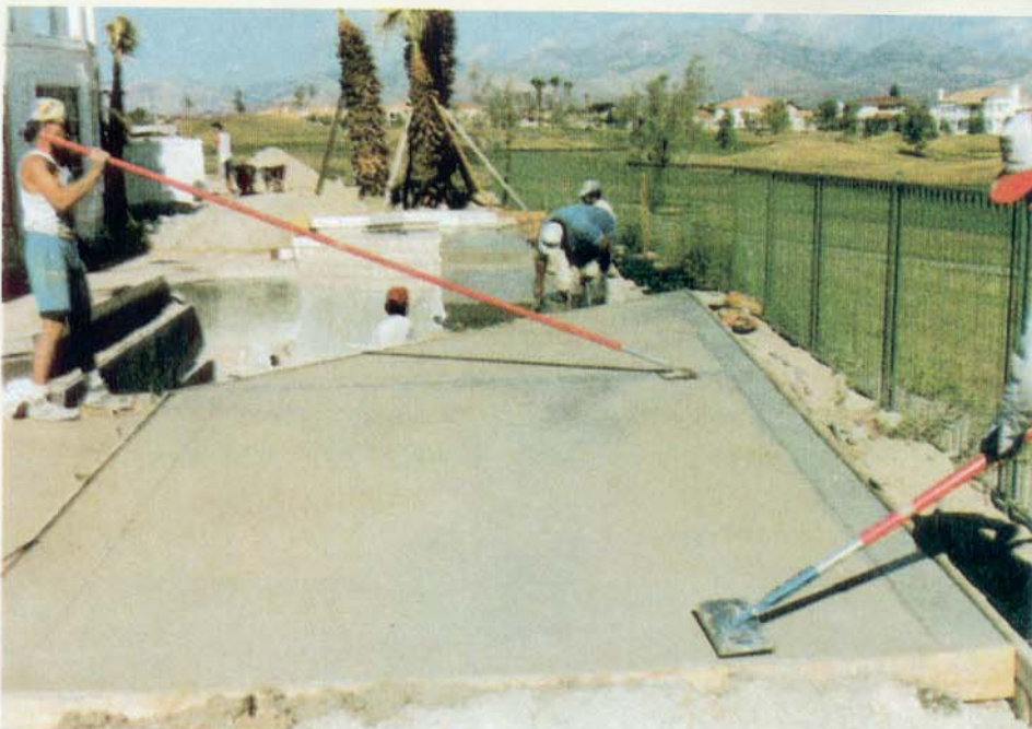
É preciso muito capricho ao dar o acabamento nas bordas do piso. O uso de fibras é obrigatório em pisos como este.
