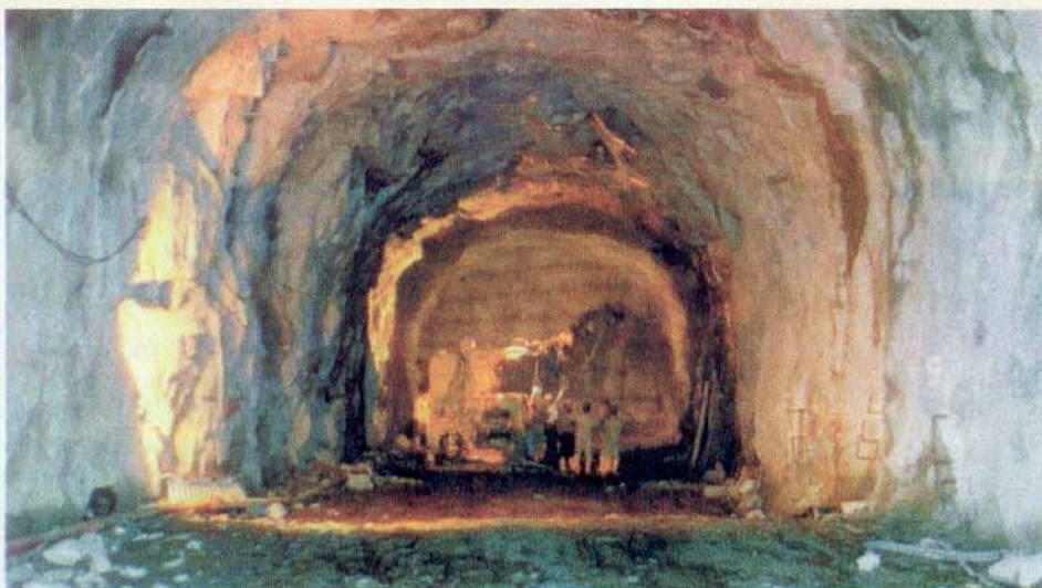
A execução de túneis em rochas através do corte a fogo provoca a que se denomina zona de alteração do corte (ZAC), comprometendo, pelo menos, um metro em torno do corte. Se houver presença d'água a injeção com microcimento tornar-se-á importante.
