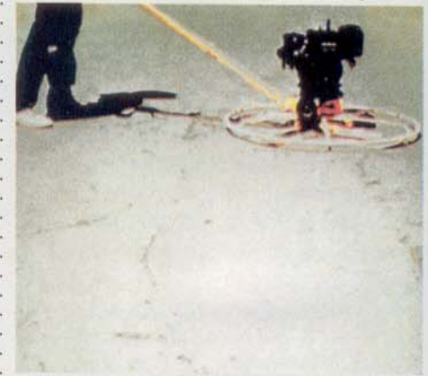
O acabamento feito com a ferramenta errada, ou mesmo utilizando-se a acabadora mecânica certa no tempo errado, dará problemas.
