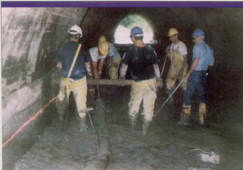
A utilização de concreto armado com fibras em uma galeria.
