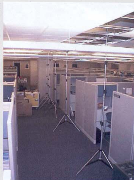
Figura 4 - Posicionamento do equipamento de monitoramento sob a linha da viga.
