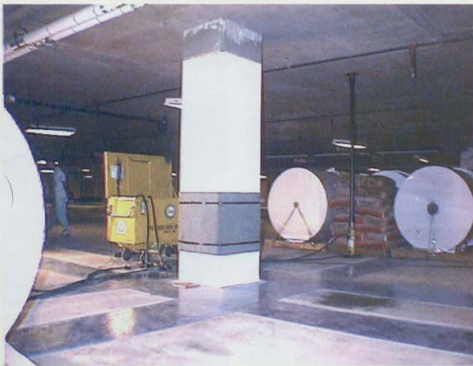
Figura 5 - Macacos de 30 toneladas reagindo contra a laje superior, previamente carregada e escovada. Sobre a laje testada foram colocados sacos de areia e rolos de papel.
