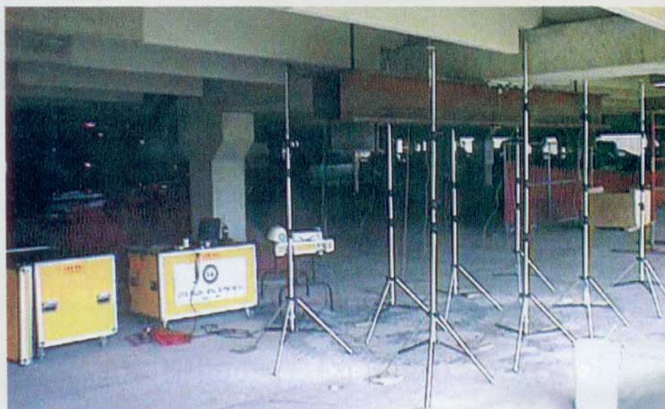
Figura 3 - ...aplicam cargas em uma viga de duplo T abaixo. O equipamento de monitoramento está a postos. Repare na reação formada pela viga metálica com tirantes nas extremidades, correspondente aos dois tirantes dos macacos na foto de cima
