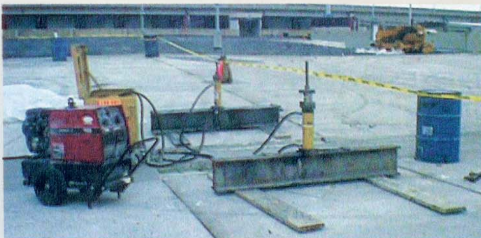
Figura 2 - Macacos hidráulicos na região superior do piso...
