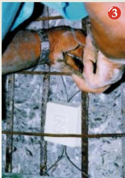
3 Instalação da Pastilha Z. É desejável que se verifique a continuidade elétrica entre a pastilha (arame de fixação) e a armadura, com um simples multimetro.
