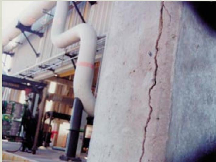
Nesta outra indústria, um dos pilares, embora com aspecto melhor que o do lado, apresenta sintomas tão ou mais graves. Repare que apresenta uma extensa trinca vertical, motivada pela alta corrosão da última camada da armadura, além de trincas de menor calibre, também verticais e paralelas. São necessários reforços estruturais e o ataque à causa da corrosão.
