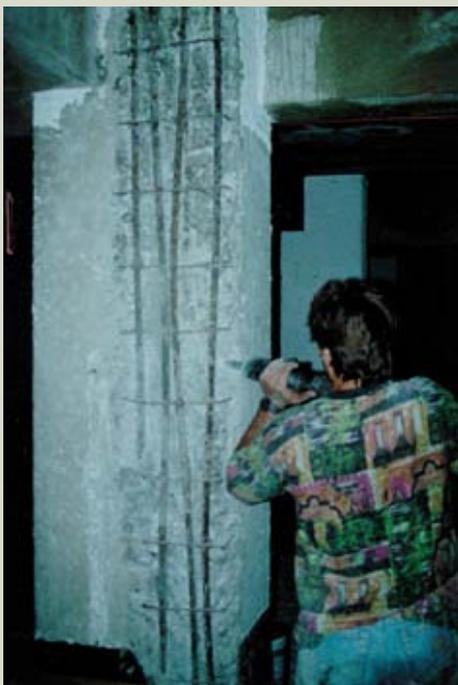
... da mesma forma que neste outro pilar onde se observa a disseminação de grandes células de corrosão, que não seja pela neutralização das correntes eletroquímicas de corrosão com aplicação da MAZ.
