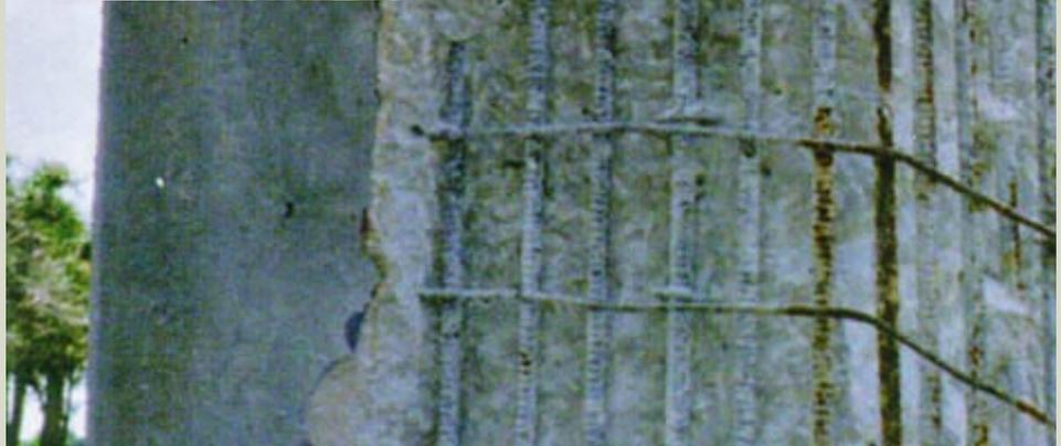
Pilar de ponte evidenciando células de corrosão com maior e menor intensidade. Repare a profundidade do corte e a existência de pequenas células (quase que pontos) de corrosão.
