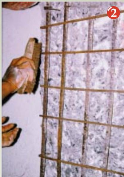
2 Após o corte e o estabelecimento da área recuperada, foi feita a instalação de novos estribos, acompanhado da escovagem para retirada das carepas de corrosão, permitindo-se uma boa ligação com os arames da pastilha. O arame é fixado com alicate.
