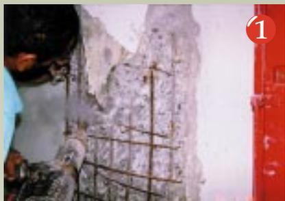
1 O corte do concreto comprometido e a surgência de armaduras em estado são.
