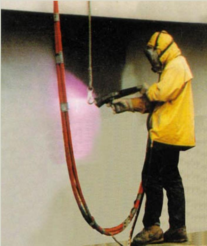
A película de ZTP mostrou ser a melhor barreira de proteção contra a corrosão, já que não apresenta os problemas inerentes às resinas como furos durante a aplicação, que arruinam a película em pouco tempo, exposição a radiação UV e a própria rigidez do filme. Com apenas meio milímetro (500 micrômetros) estabelece-se um plano de garantia superior a 20 anos.
