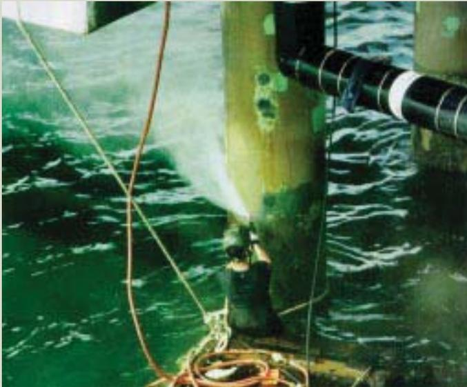
Na zona de variação da maré é onde acontecem os principais danos nas estacas. Uma boa limpeza torna-se necessário para se diagnosticar o estado da estaca.
