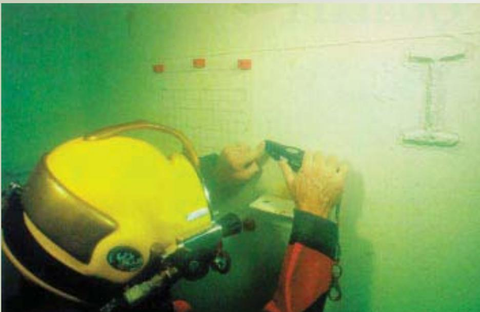
O mergulhador mede a espessura da película existente. Repare no traçado da malha.
