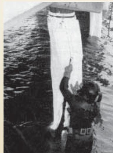
...com a utilização de jaquetas de pano sintético resistente e fecho éclair. O restabelecimento físico da seção do concreto e das armaduras não significa o fim da recuperação. A presença de corrosão pede, adicionalmente, um tratamento eletroquímico com anodos de sacrifício ou Jaquetas G.
