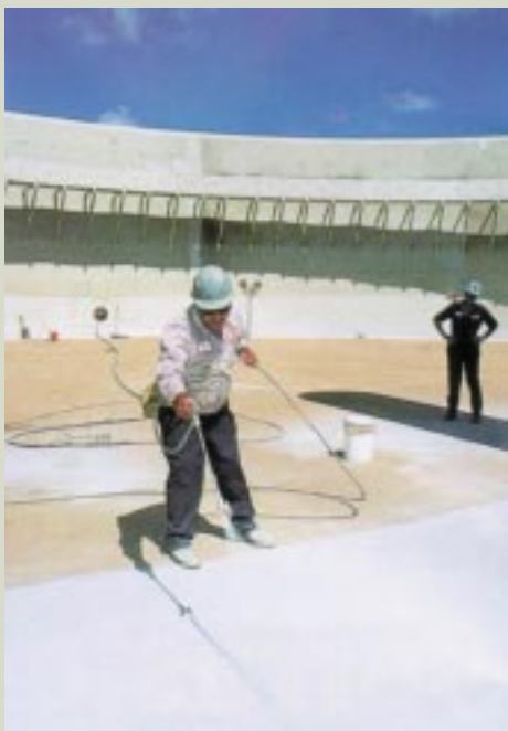
A utilização de airless aumenta muito a produção acarretando, no entanto, perdas maiores.
