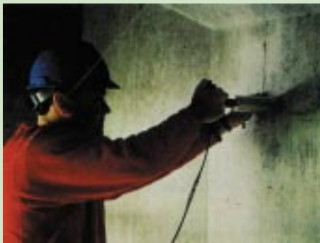
Figura 4 - O transducer com os mini percursores em forma de estrela, posicionados ao longo do local onde corre um cabo de protensão, dentro de uma viga caixão.
