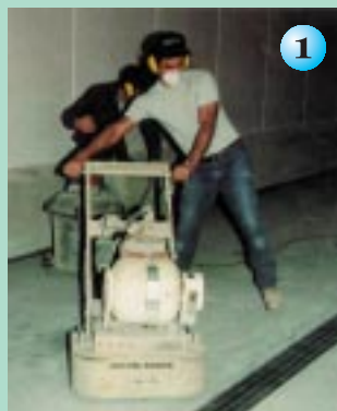
Preparação do piso.
