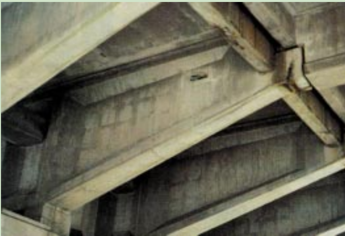
Figura 2 - Vigas em balanço pré-moldadas e protendidas de um viaduto.
