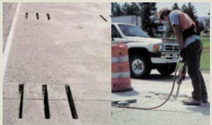
Figura 10C - Os cortes são feitos ao longo da linha de ação dos pneus. À seguir entra-se com um martete para remover o concreto cortado.
