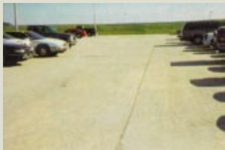
Figura 6 - A fresagem corrige superfícies mal acabadas.
