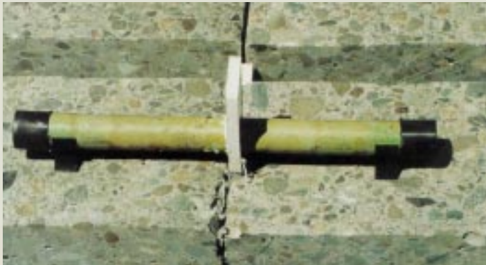
Figura 9 - Barra de recuperação preparada para ser instalada na cavidade. As duas cápsulas de plástico extremas deverão ser fixadas com folga, para permitir que a junta abra ou feche, após a sua instalação. A esponja central impede que a argamassa de recuperação adentre na junta.
