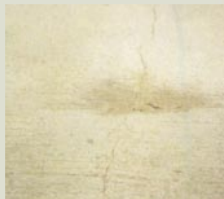
Figura 1 - Fissuras.
