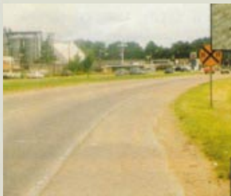
Figura 5 - Vazios identificados por manchas escuras na superfície.
