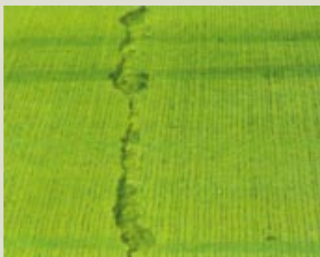
Figura 3 - Trinca com deslocamentos.
