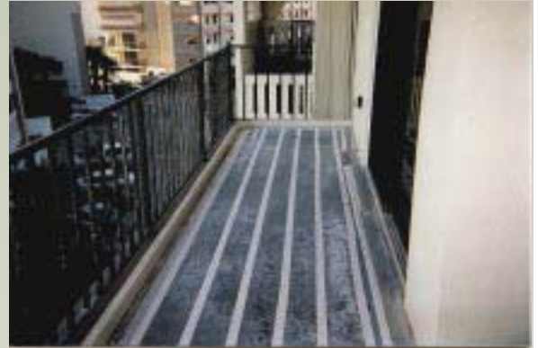
A MAZ aplicada na laje da varanda. A seguir, foi aplicado revestimento cerâmico.
