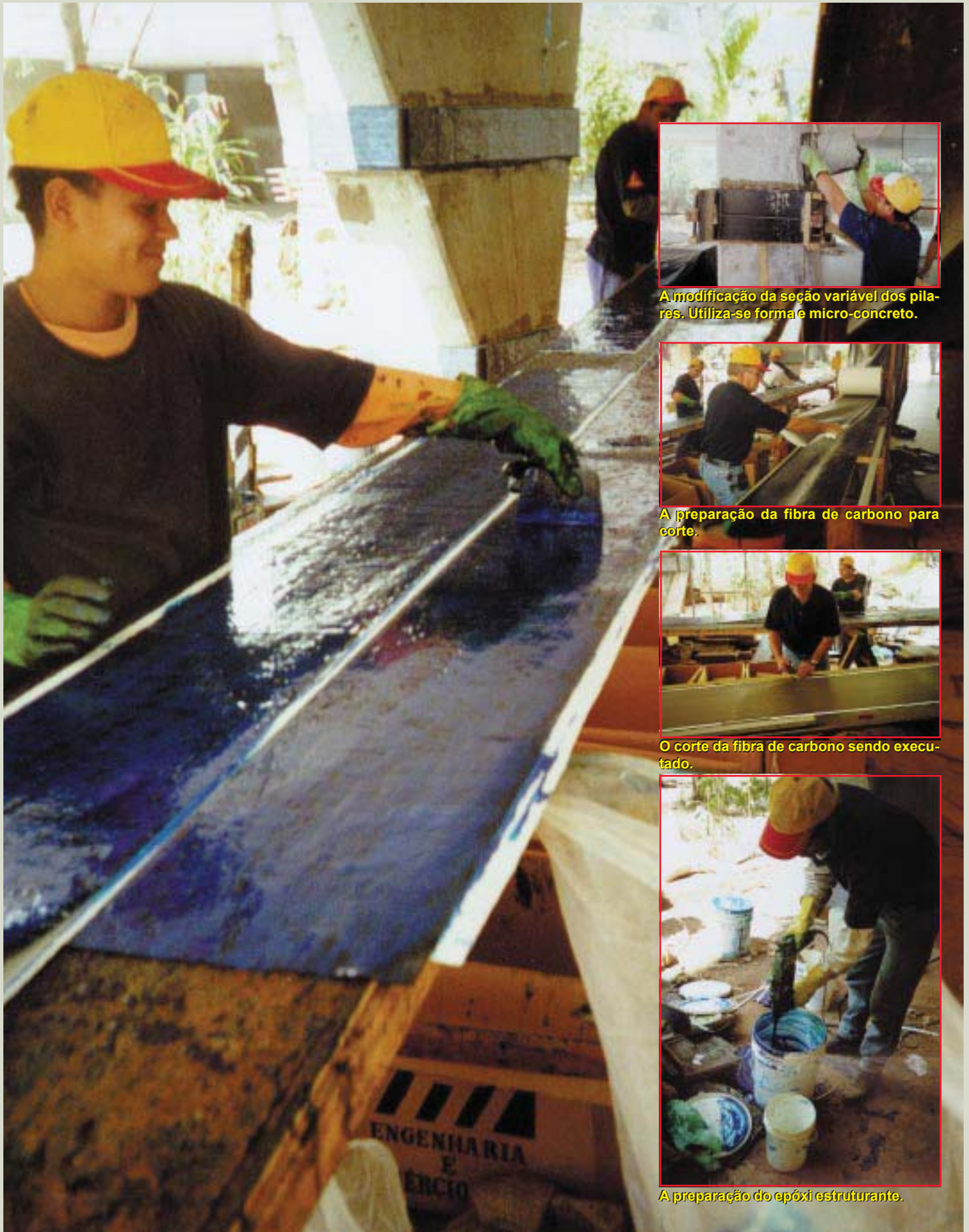
A impregnação do tecido de fibra de carbono com epóxi estruturante.
