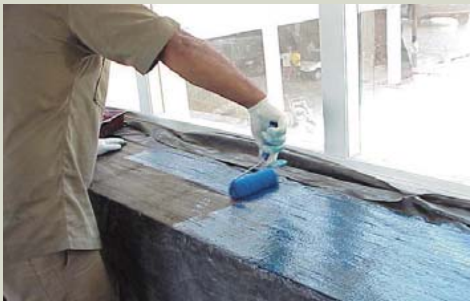
A aplicação do epóxi estruturante na fibra de carbono.
