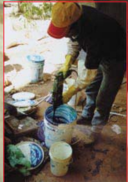
A preparação do epóxi estruturante.
