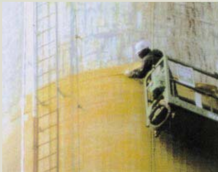
A aplicação de fibras de Kevlar em torno de um tanque de concreto.
