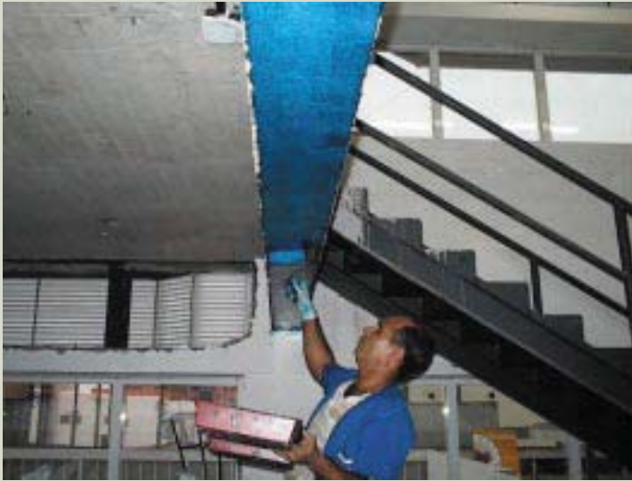
O reforço no fundo da viga V11a.
