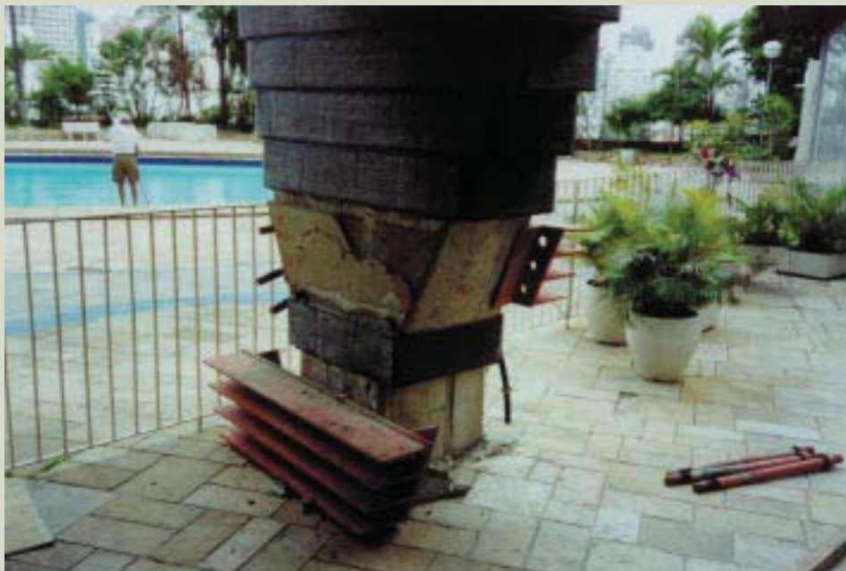
A remoção do reforço com estrutura metálica em andamento...
