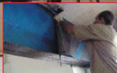
O reforço, para esforços de cisalhamento, feito com fibra de carbono, nos cantos da viga V11a.
