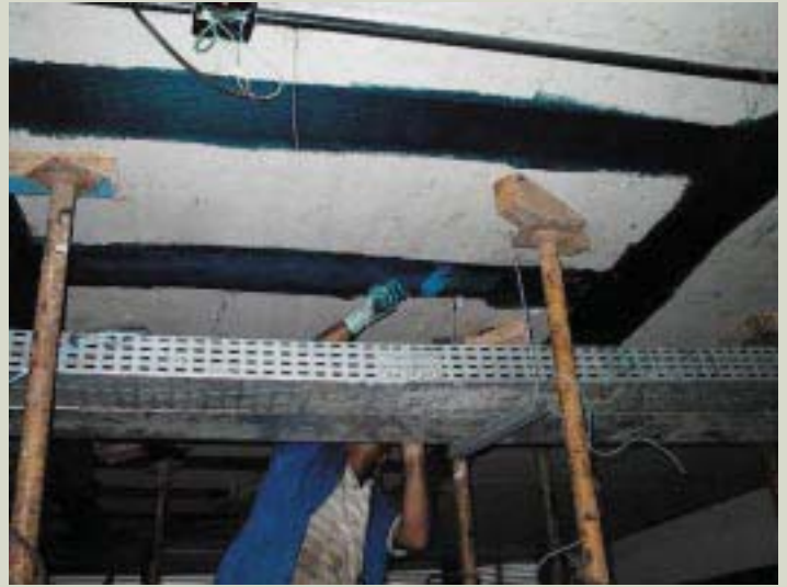
A aplicação da fibra de carbono na laje.
