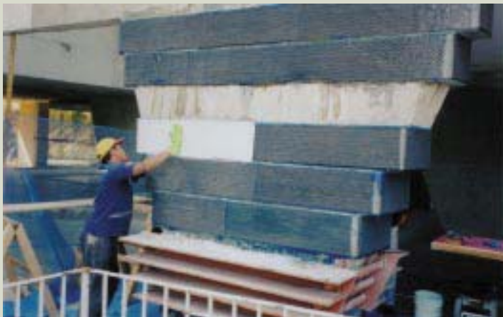
Os diversos níveis de aplicação do reforço com fibra de carbono.
