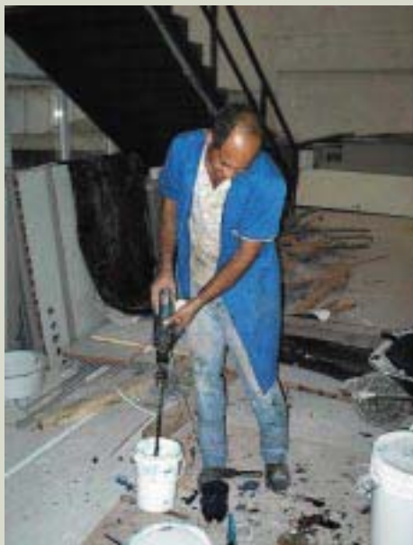
A mistura do epóxi estruturante.
