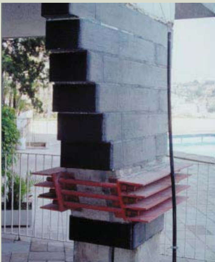
Situação típica de um pilar já reforçado com fibra de carbono, esperando o tempo de cura de 7 dias para remoção do antigo reforço metálico existente.
