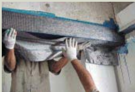
A 2ª camada sendo aplicada na região inferior da viga V11a.
