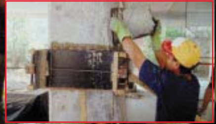
A modificação da seção variável dos pilares. Utiliza-se forma e micro-concreto.
