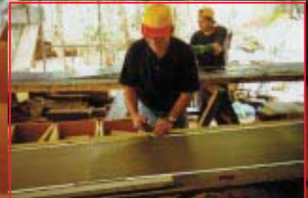
O corte da fibra de carbono sendo executado.
