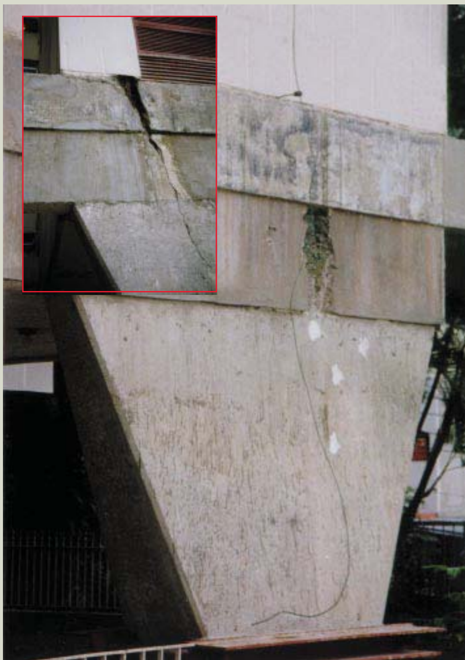
A situação dos pilares com trincas e fissuras verticais é evidenciada neste exemplo.
