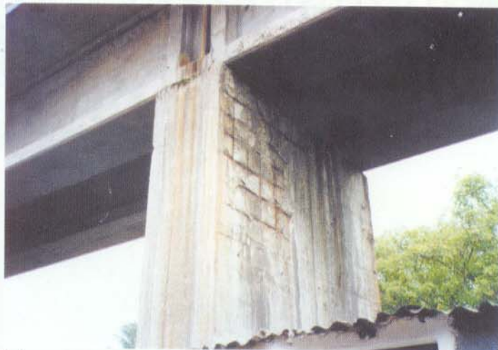
A presença de corrosão deve ser investigada e neutralizada por processo eletroquímico, sem o que comprometerá o reforço.
