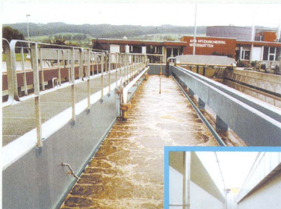
Nos tanques de aeração onde existem os difusores de membranas há a necessidade de se aplicar a bisfenol F com agentes de cura cicloalifáticos (veja tabela na pág. 8).
