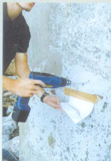
Extrai-se o pó do concreto a várias profundidades...
