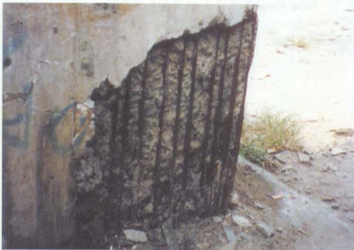
A presença de corrosão deve ser investigada e neutralizada por processo eletroquímico, sem o que comprometerá o reforço.
