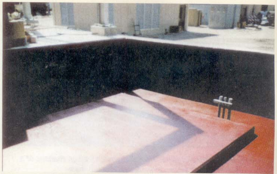
Estocagem secundária (ver RECUPERAR nº 22) em uma ETE. Aqui, poder-se-á utilizar uma resina novolac ou bisfenol F com um agente de cura aminocicloalifático.
