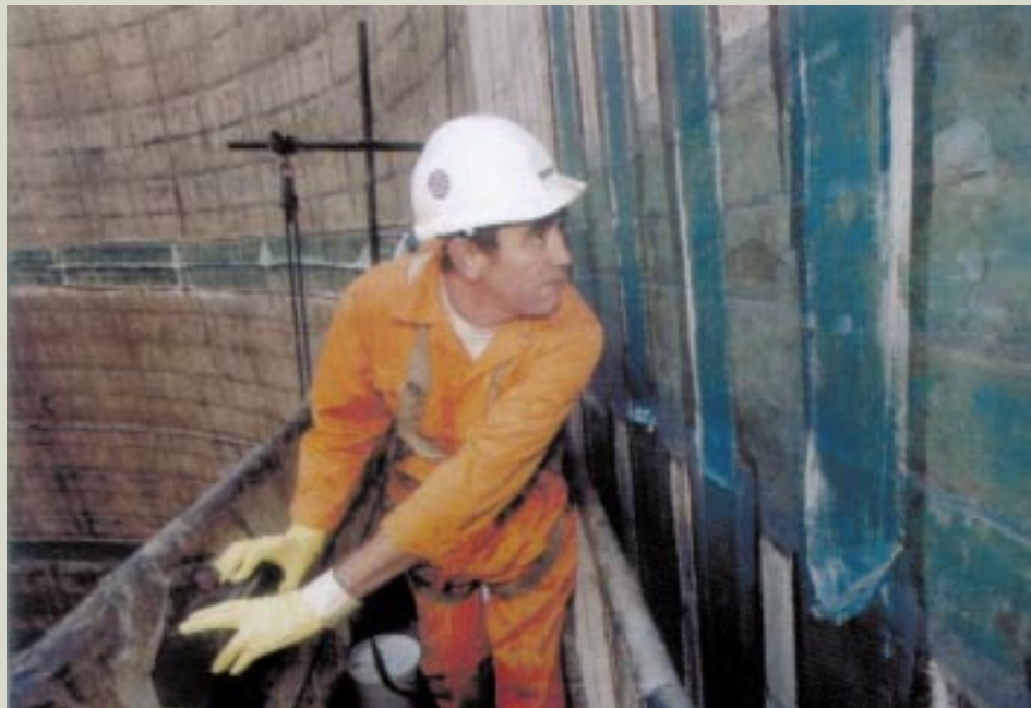
Faixas de Kevlar já fixadas.
