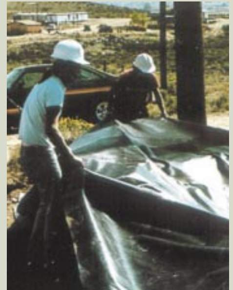
A flexibilidade da geomembrana de poliéster permite a instalação em situações difíceis.
