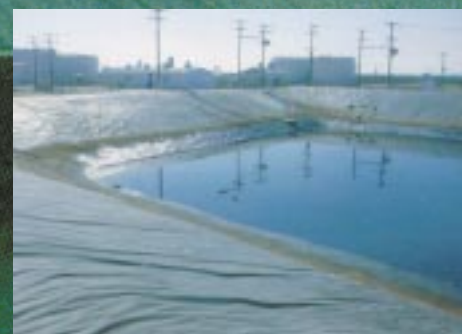
Geomembranas mais flexíveis têm grande capacidade de esticar, sem qualquer perda em sua performance. É o caso das geomembranas de PVC, PET e PEMBD.
