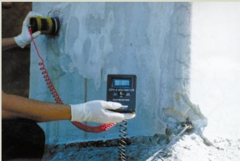
Repare que neste pilar foi necessário fazer um leve apicoamento na região de instalação do eletrodo da semi-pilha, já que havia um revestimento epóxico.
