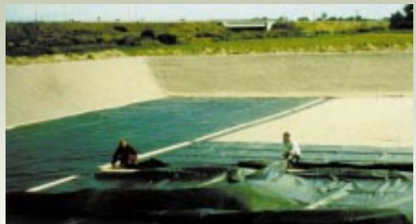
A utilização de geomembranas de PVC, PET e PEMBD é facilitada com o fornecimento de grandes painéis, diminuindo substancialmente as emendas.
