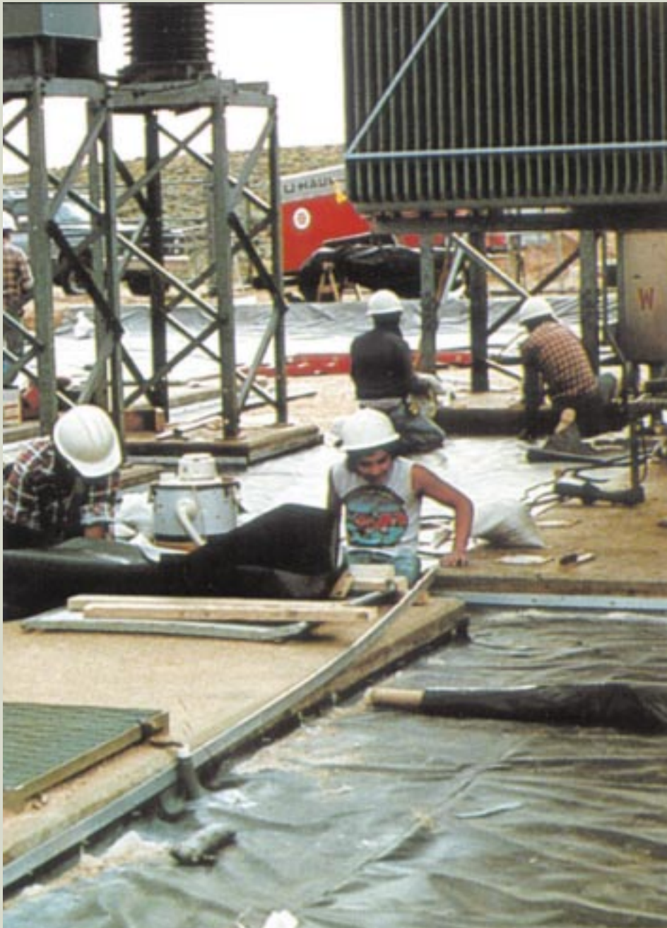
A grande quantidade de emendas e o controle de qualidade são fases consideradas críticas na utilização das geomembranas.
