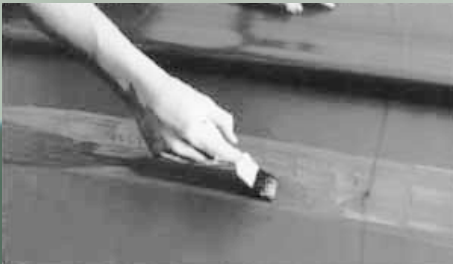
A emenda feita com a aplicação do adesivo químico...
