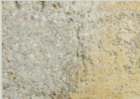
À medida que executa-se o desbaste na superfície, retirando-se películas e sugidades indesejáveis, é comum a surgência de pequenas cavidades que devem ser preenchidas com masa epóxica (após o primer).
