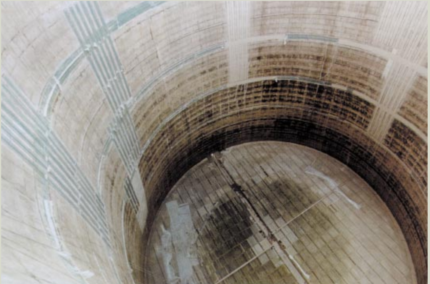
Vista superior das áreas reforçadas.
