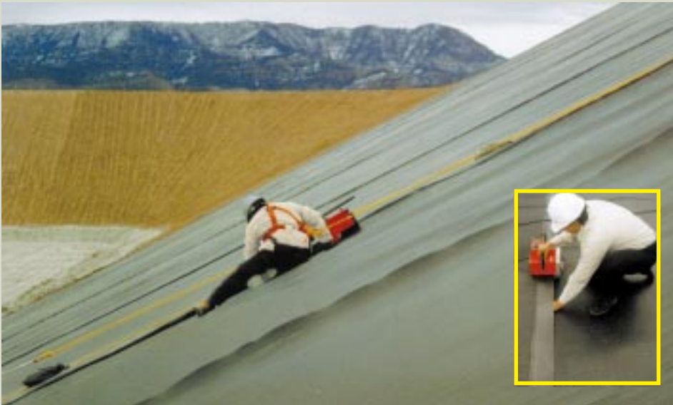
O uso de geomembranas de PEMBD traz inúmeras vantagens em relação às de PEAD. No detalhe, a solda sendo feita numa geomembrana de PEMBD texturada. Repare que a borda é lisa, para permitir a emenda com equipamento térmico.
