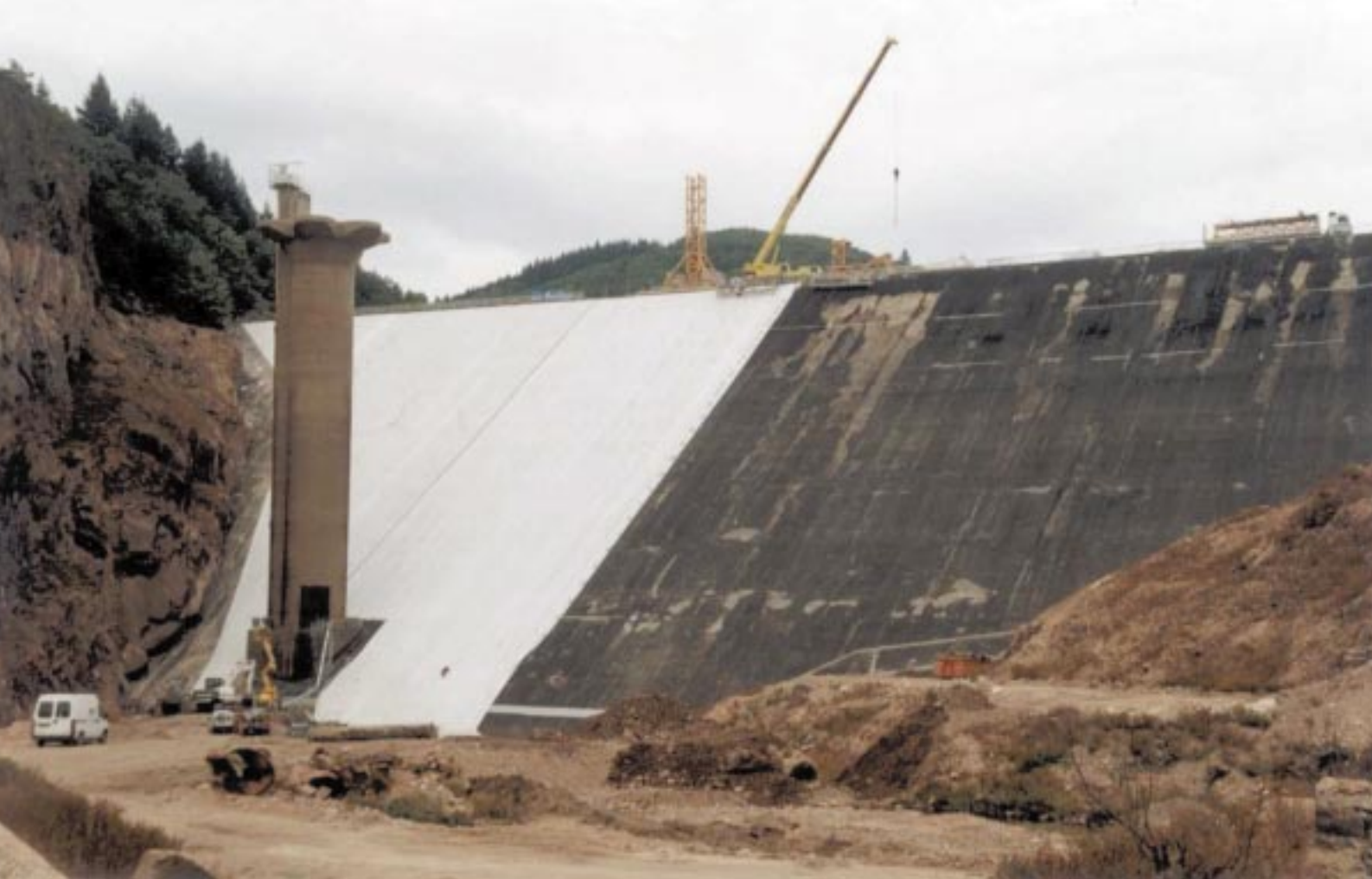
A aplicação de geomembrana de PVC/geotextil na recuperação de uma barragem de terra.
