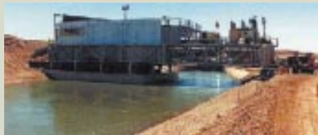
O canal com a draga e a pavimentadora.
