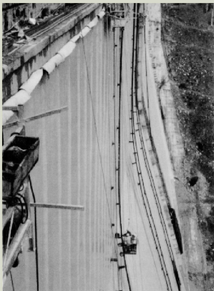
Instalação da geomembrana/geotextil na barragem de Pracana.
