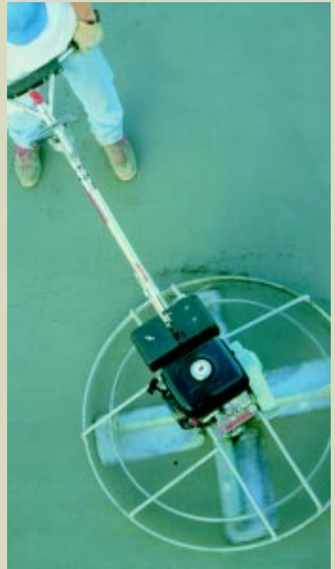
Após a aplicação da acabadora mecânica é recomendável a aplicação de endurecedores de superfície para curá-la e endurecê-la.
