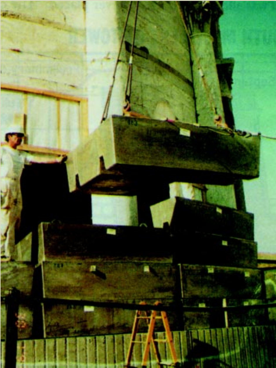
Os contrapesos de chumbo sendo posicionados no lado norte.
