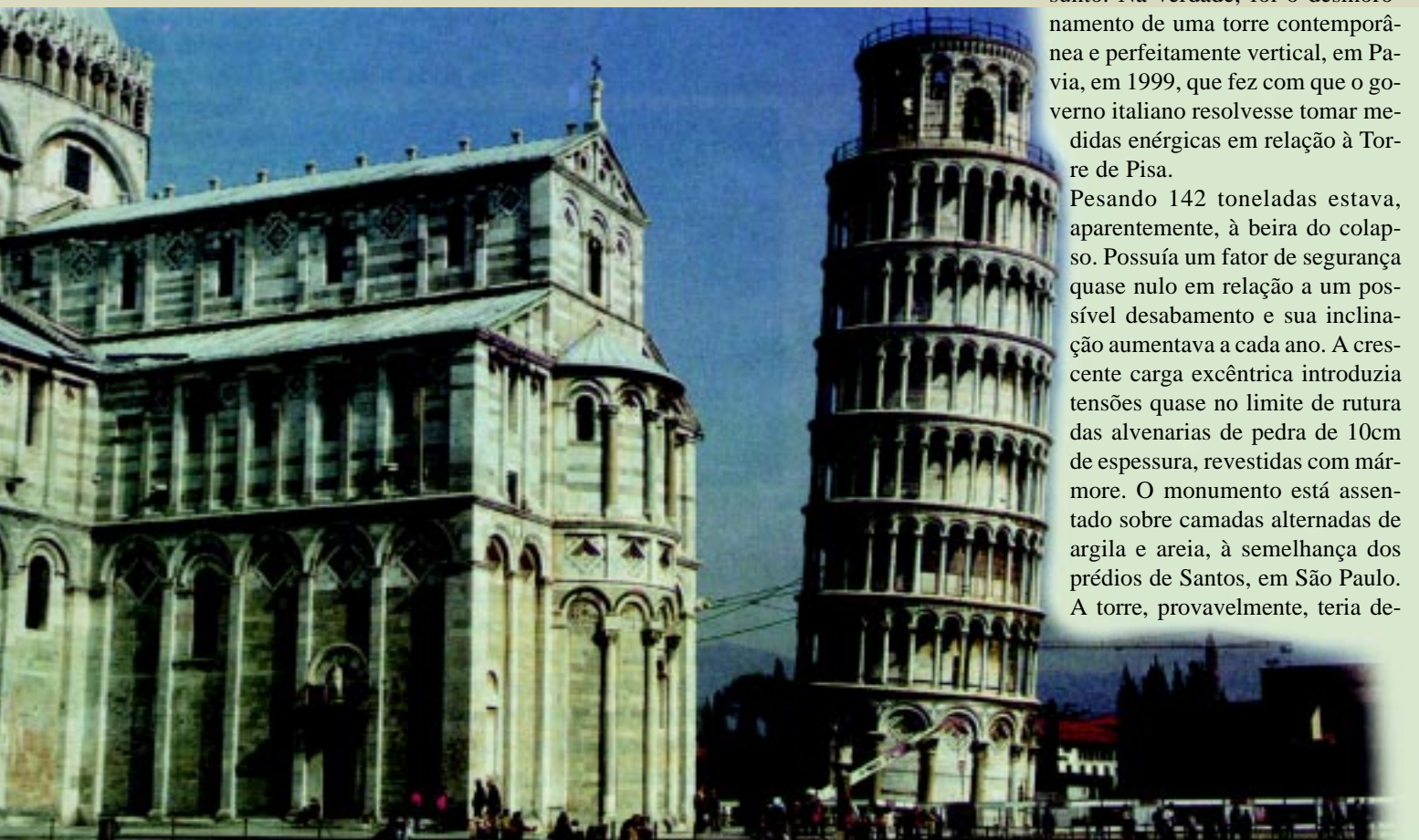
A torre de PISA durante os trabalhos de recuperação. Note os cabos de aço fixados em torno da torre.
