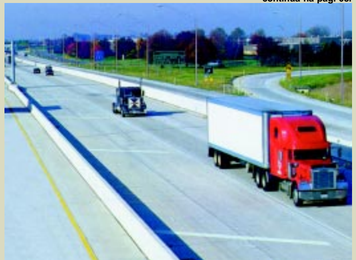
O uso de endurecedores em pistas de concreto é fundamental para sua durabilidade.
