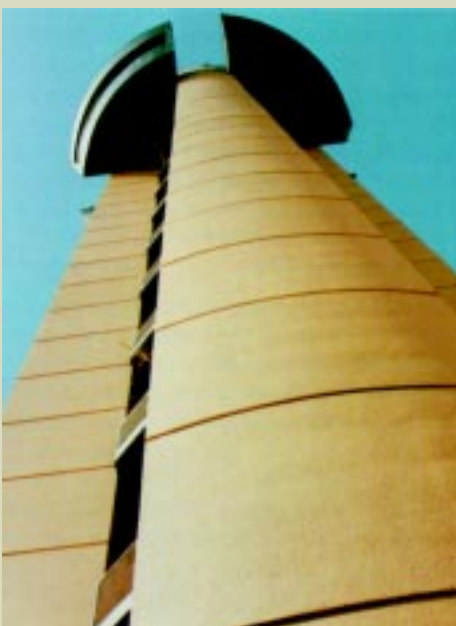
A performance das tintas de silicato garantem uma durabilidade até então impossível com as tintas latex. Após cerca de dez anos, normalmente, as fachadas necessitam apenas de uma lavagem.
