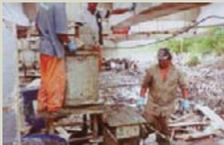
O serviço de Permeation Grouting: a bomba e o misturador.
