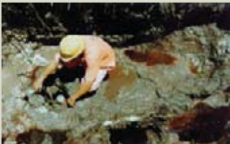
Visão do buraco feito para constatação da primeira "laje" criada com PG. Na foto da direita veja o detalhe do buraco
