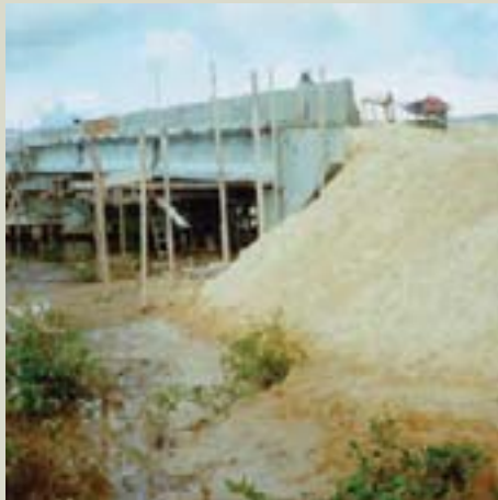
Os 4m de aterro sobre a área tratada.
