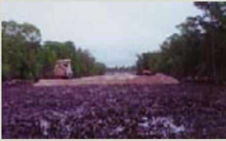
O aterro, no solo de mangue, de encontro ao viaduto.
