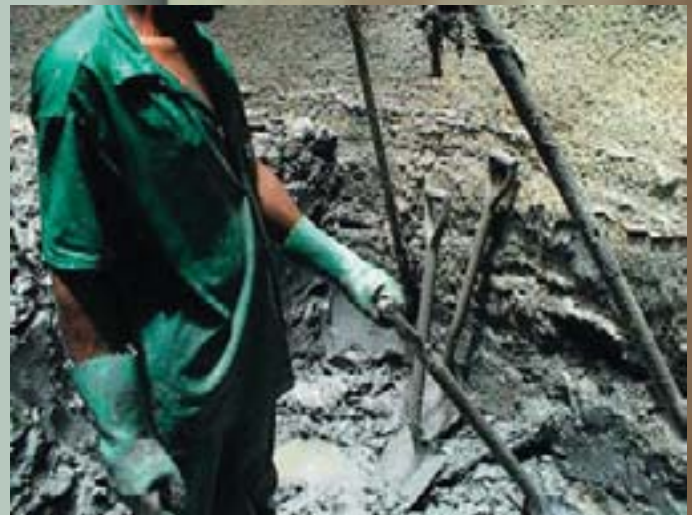
Após a execução da PG obteve-se a consolidação necessária à escavação para retirada do equipamento enterrado.
