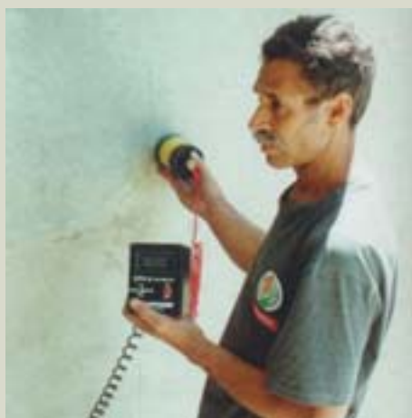
A análise dos potenciais é fundamental no controle da corrosão.
