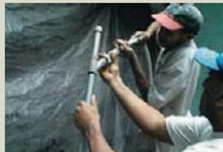
...e o posicionamento da mangueira para posterior injeção de PG.
